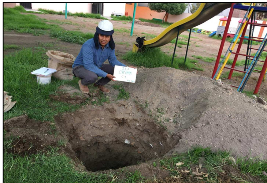
Fotografía 2: Excavación de calicata C-01
