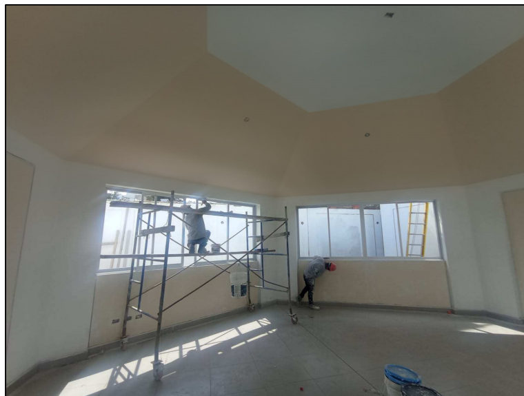
Fotografía 17: Vista del acabado del interior del aula.
