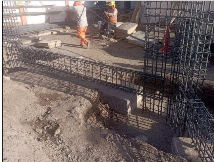
Fotografía 12: Acero de refuerzo en vigas de cimentación.
