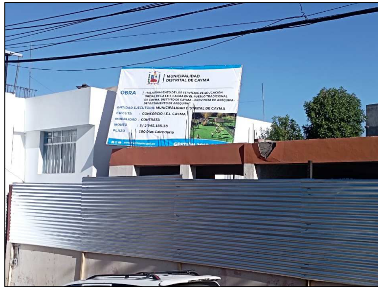
Fotografía 4: Cartel de obra.
