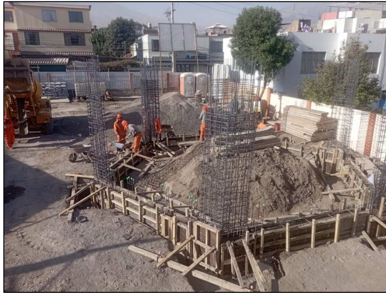
Fotografía 14: Placa en V de las aulas.
