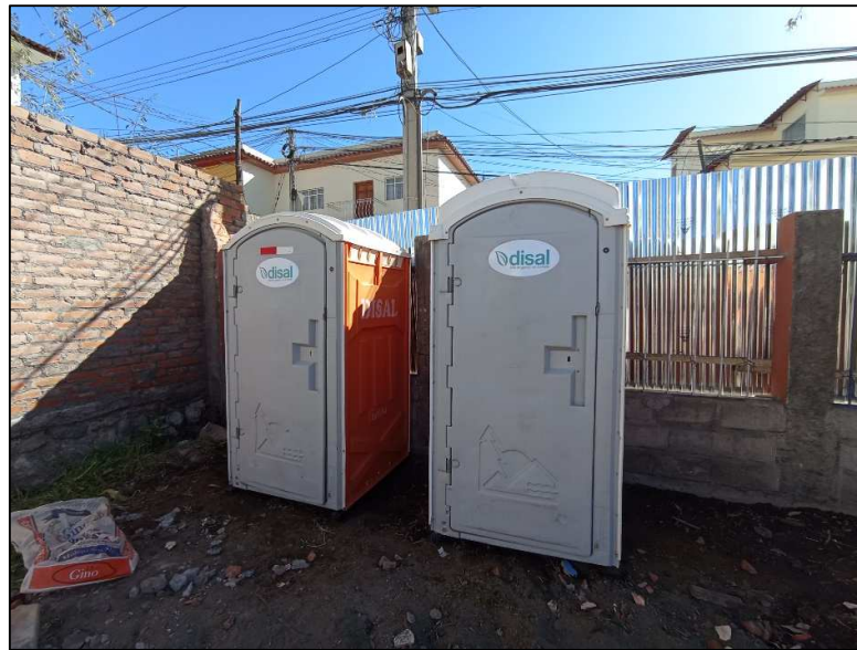
Fotografía 5: Implementación de servicios higiénicos en la obra.
