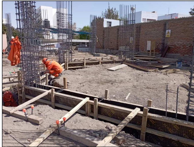
Fotografía 13: Encofrado de vigas de cimentación.
