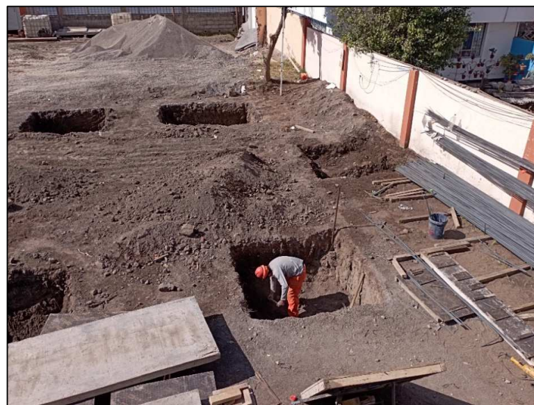
Fotografía 10: Excavación de zanja para zapatas.
