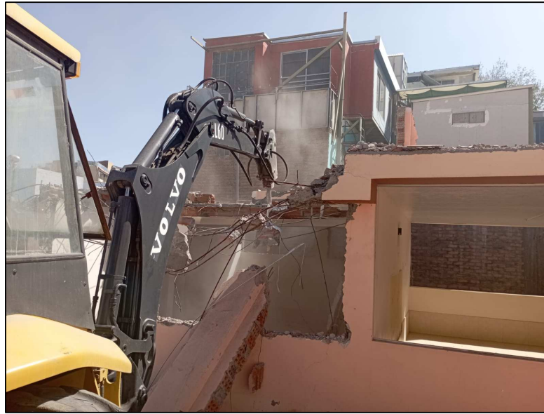
Fotografía 7: Demolición con maquinaria.
