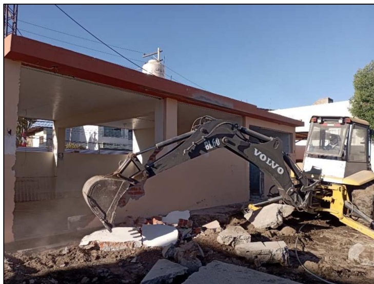
Fotografía 6: Demolición de aulas existentes.
