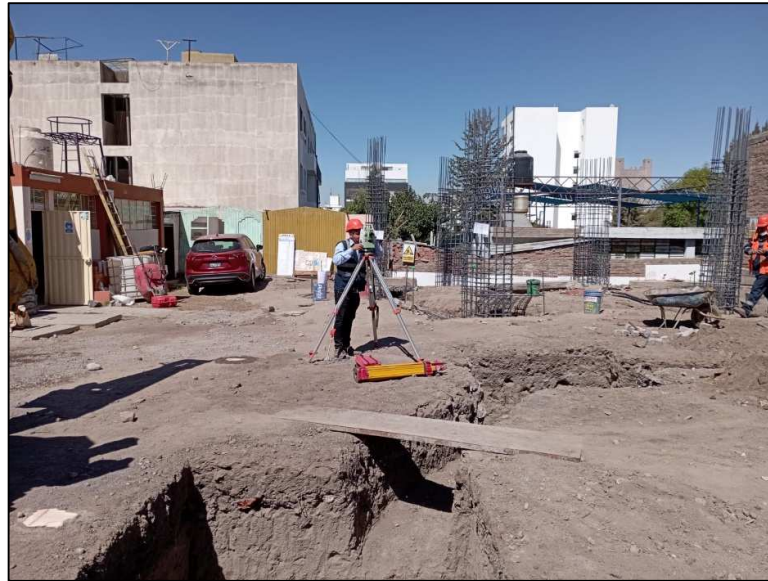
Fotografía 9: Trazo y replanteo en obra
