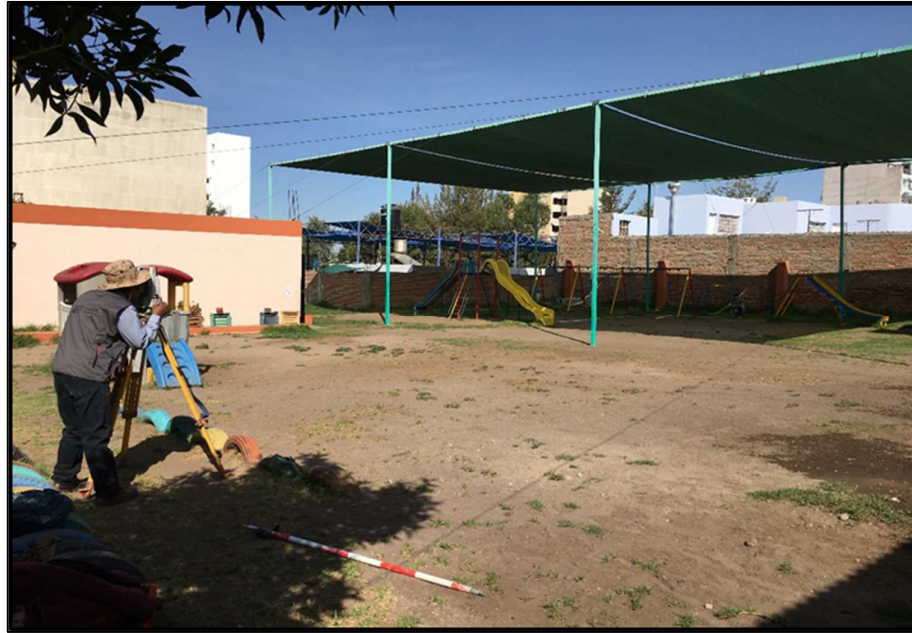
Fotografía 1: Trabajos de levantamiento topográfico.
