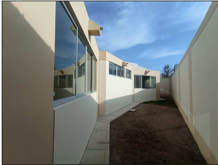
Fotografía 18: Vista del acabado del exterior de las aulas.
