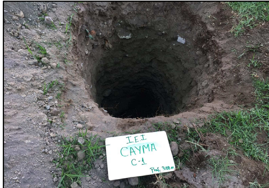
Fotografía 3: Profundidad de excavación de calicata C-01
