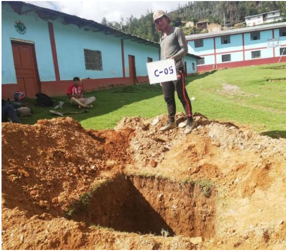
Ilustración 9 - Calicata 05 Panorámico y Estratos (Red de Distribución)
