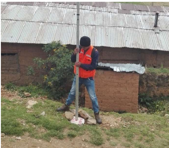
Ilustración 19 - Nivelación de la Poligonal Cerrada
