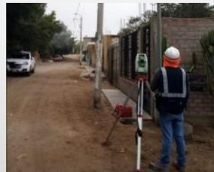
Proceso de levantamiento topográfico, Referencia: Tramo I (Camino los Leones Pueblo Nuevo)
