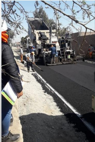
Imágenes del proceso de asfaltado . Referencia: Tramo I (izq.), Tramo V(dcha.)
