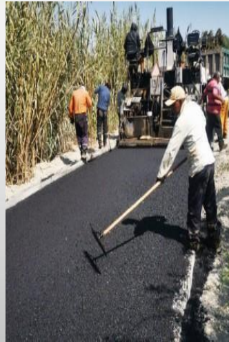
Imágenes del proceso de asfaltado . Referencia: Tramo I (izq.), Tramo V(dcha.)
