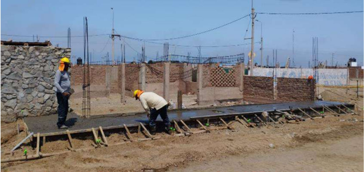
Foto 6. Encofrado de madera en veredas
