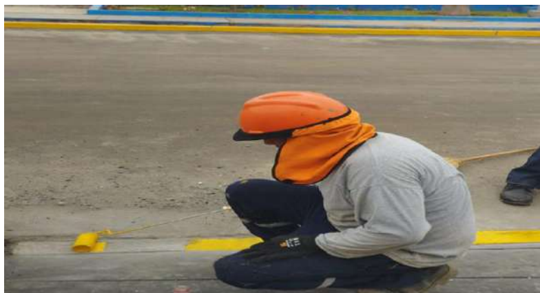
Foto 17. Pintado de líneas en el Pavimento
