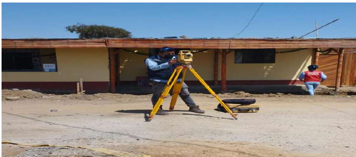
Foto 1. Replanteo con Equipo topográfico.
