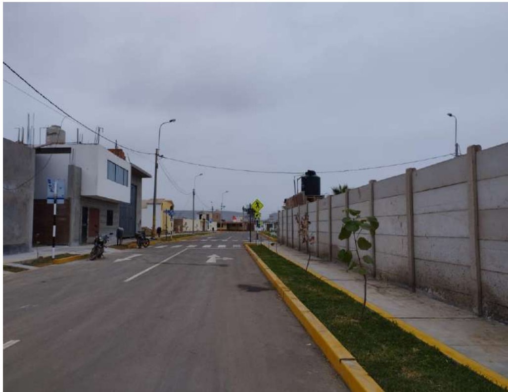
Foto 22. Pavimento, veredas, sardinel y Rampa en Av. 28 de Julio
