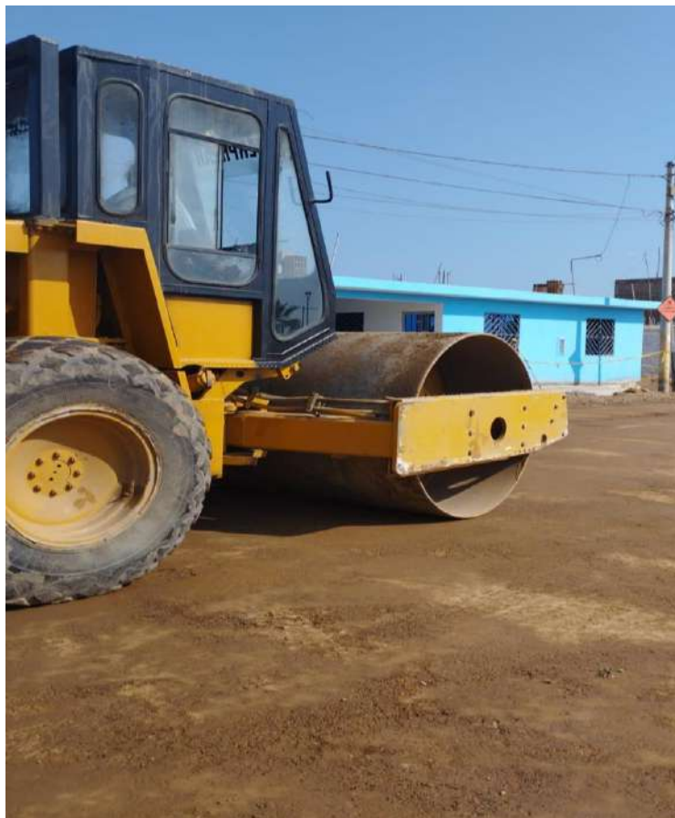
Foto 12. Relleno con material de préstamo Compactado con equipo.
