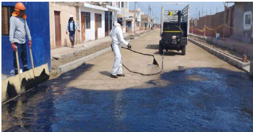
Foto 13. Imprimación Asfáltica.
