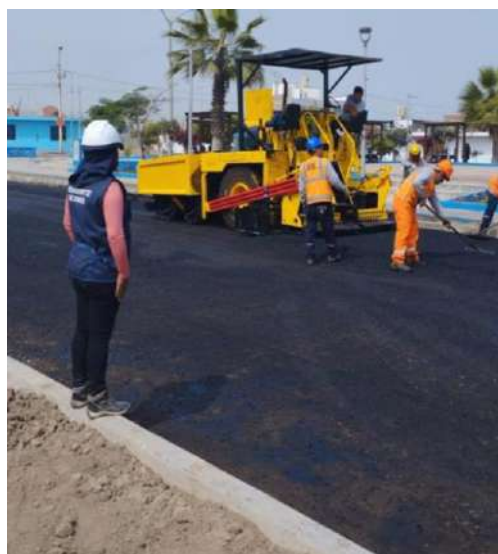
Foto 14. Imprimación Asfáltica.
