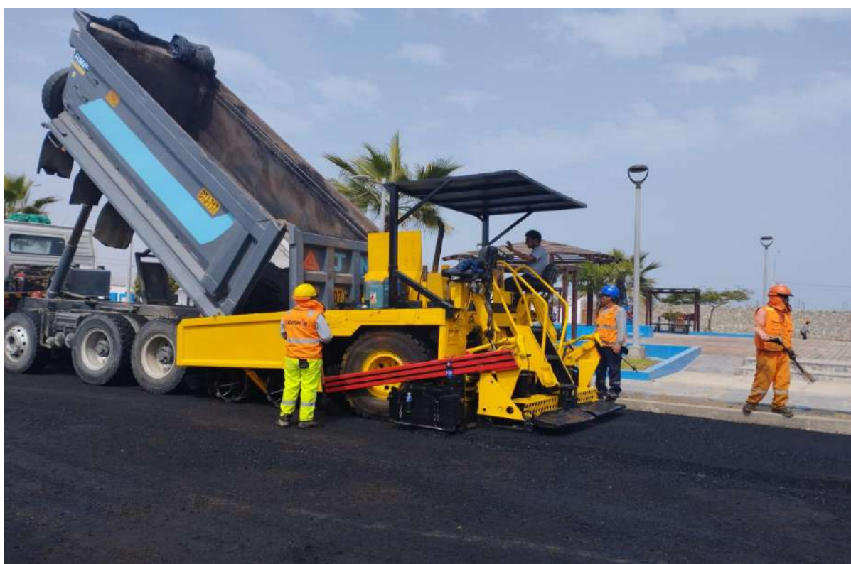
Foto 15. Colocación de Carpeta Asfáltica en Caliente E=2".
