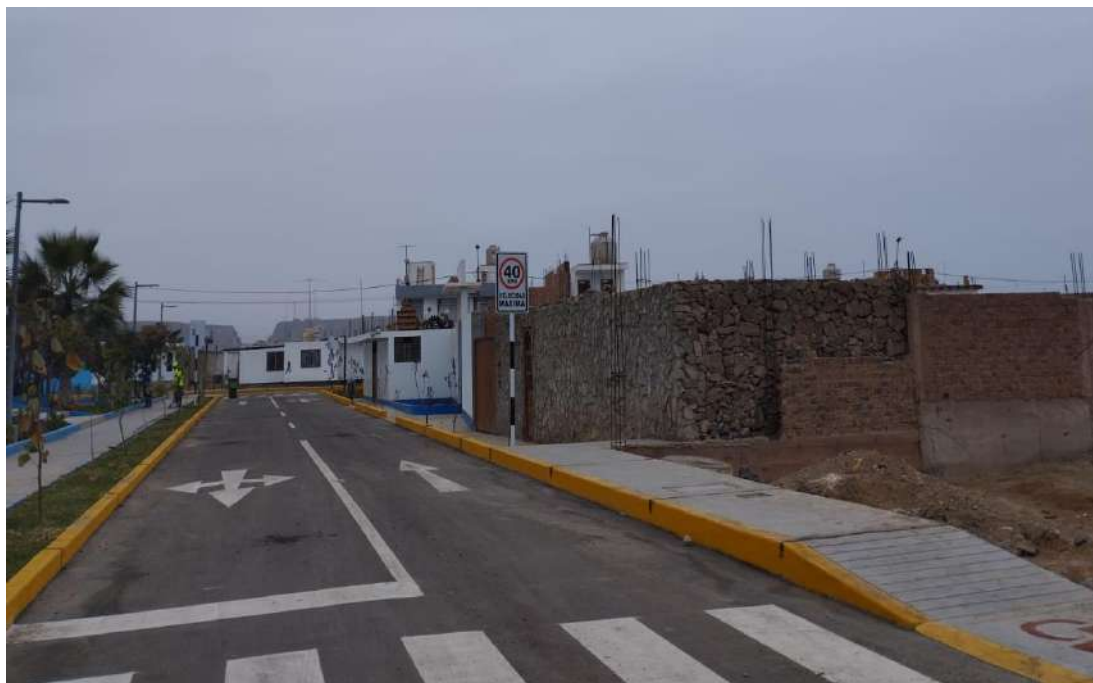
Foto 23. Pavimento, veredas, sardinel y Rampa en Calle S/N.
