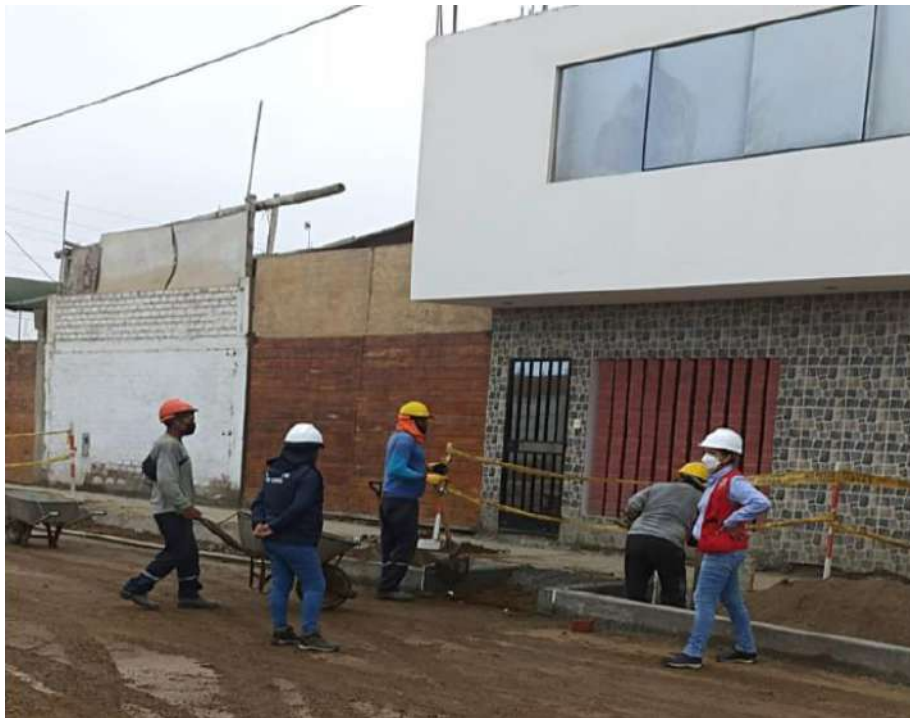
Foto 9. Concreto en Rampa H=0.10\text{m} , f'c 175\text{kg/cm}^2 .
