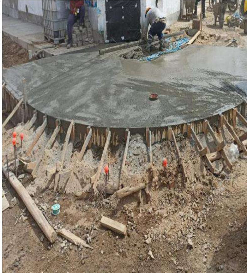
Foto 8. Concreto en Martillo H=0.10\text{m} , f'c 175\text{kg/cm}^2 .
