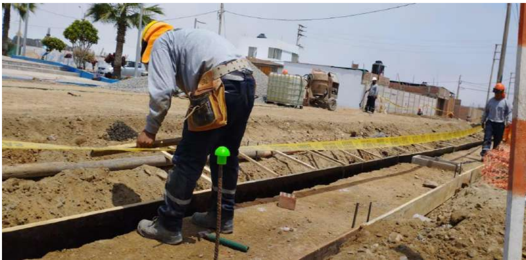
Foto 3. Encofrado de Vereda
