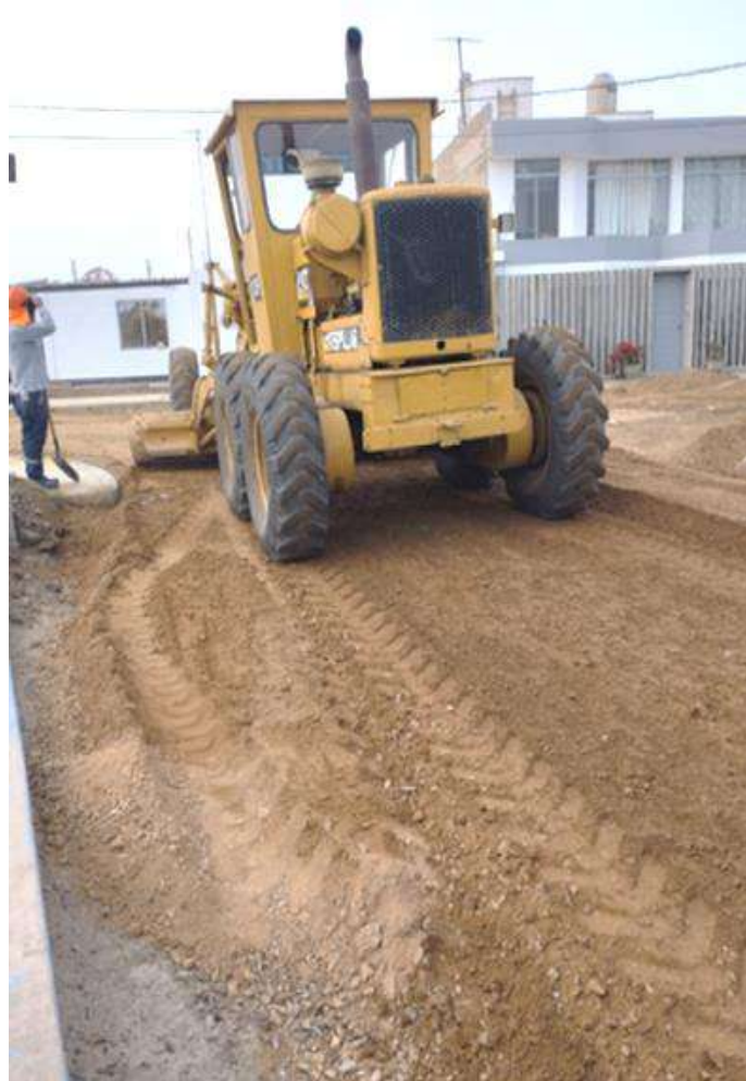
Foto 11. Corte a nivel de subrasante.
