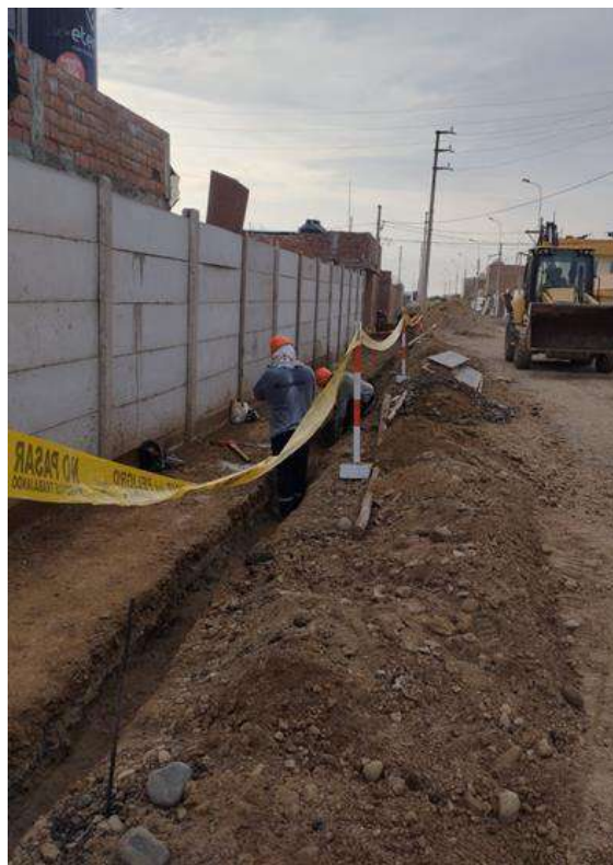
Foto 7. Concreto ciclópeo en uña.
