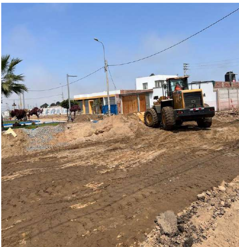
Foto 2. Corte del Terreno a nivel de Subrasante.
