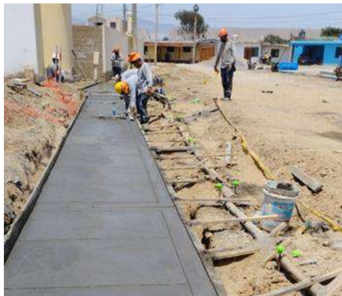
Foto 5. Vaciado de concreto en Veredas Av. 28 de Julio, H= 0.10m
