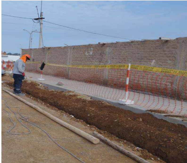
Foto 4. Veredas de concreto simple en veredas en la Joya.
