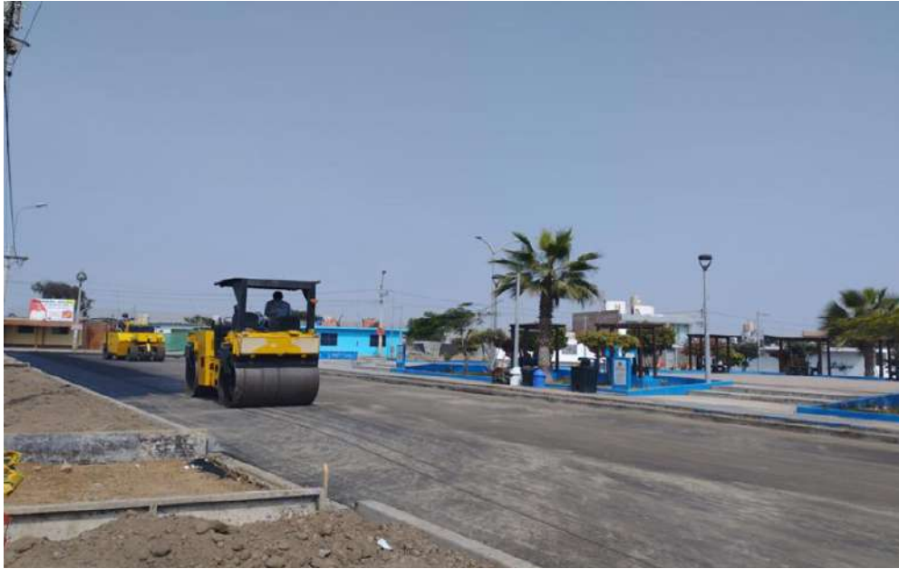
Foto 16. Sellado de superficie de Rodadura con Arena.
