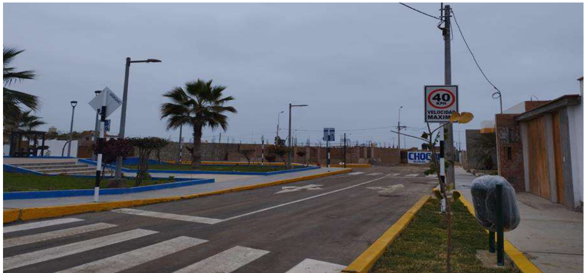
Foto 21. Pavimento, veredas, sardinel y Rampa en Pasaje Melchorita
