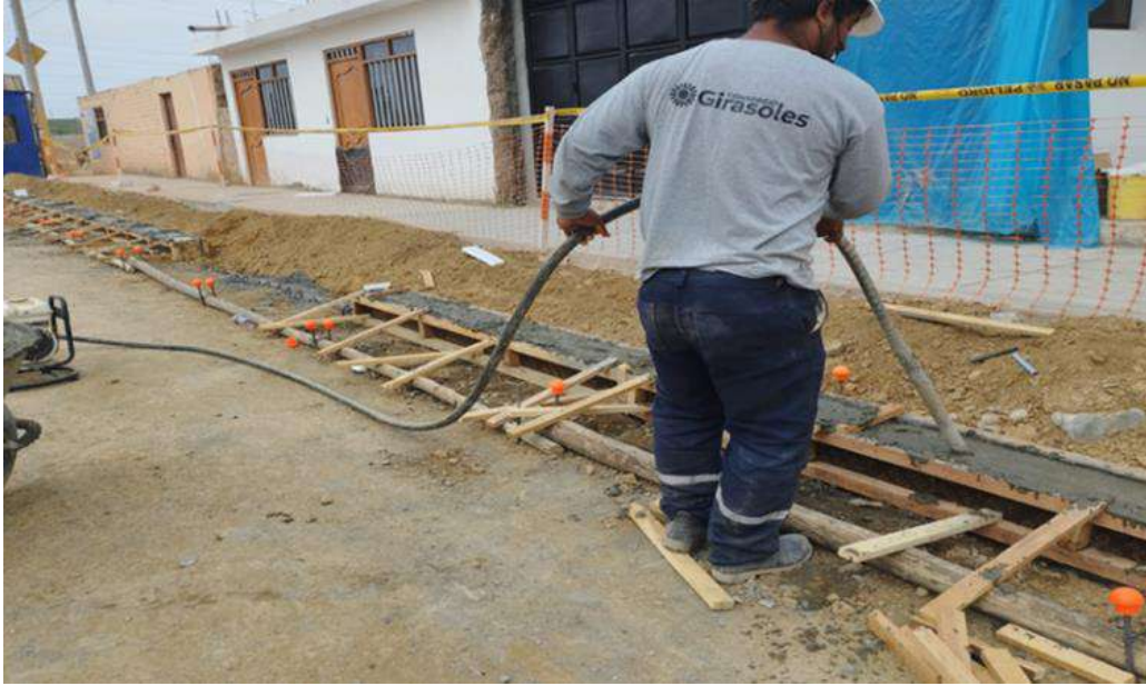
Foto 10. Concreto Armado para Sardinell f'c 175kg/cm 2 .
