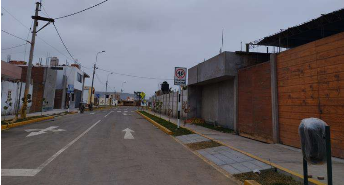
Foto 20. Pavimento, veredas, sardinel y Rampa en Av. 28 de Julio
