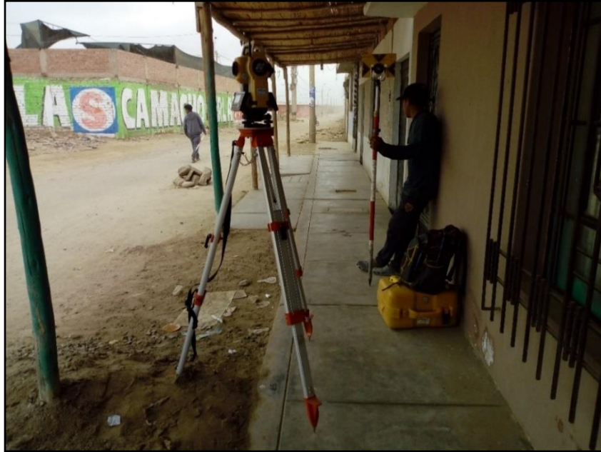
Instalación de equipo topográfico para trabajos de campo
