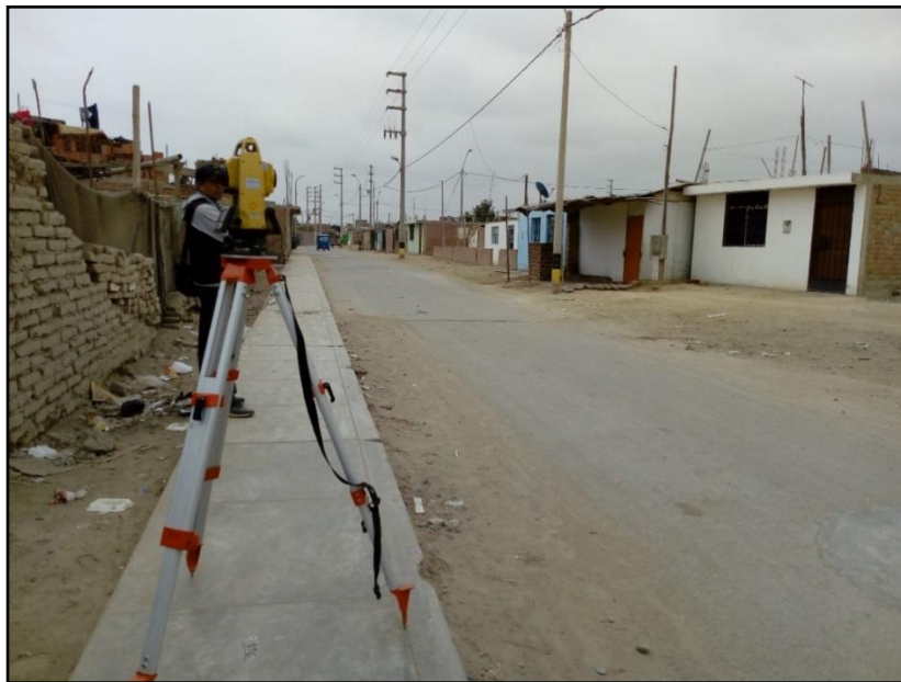
Personal de topografía realizando los trabajos en la ca. Los Héroes
