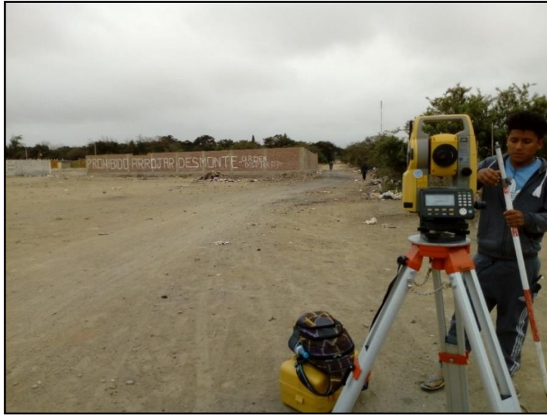
Personal de Topografía recolectando información de campo en la intersección De Ca. San Pablo Con Prolg. Calle 7.
