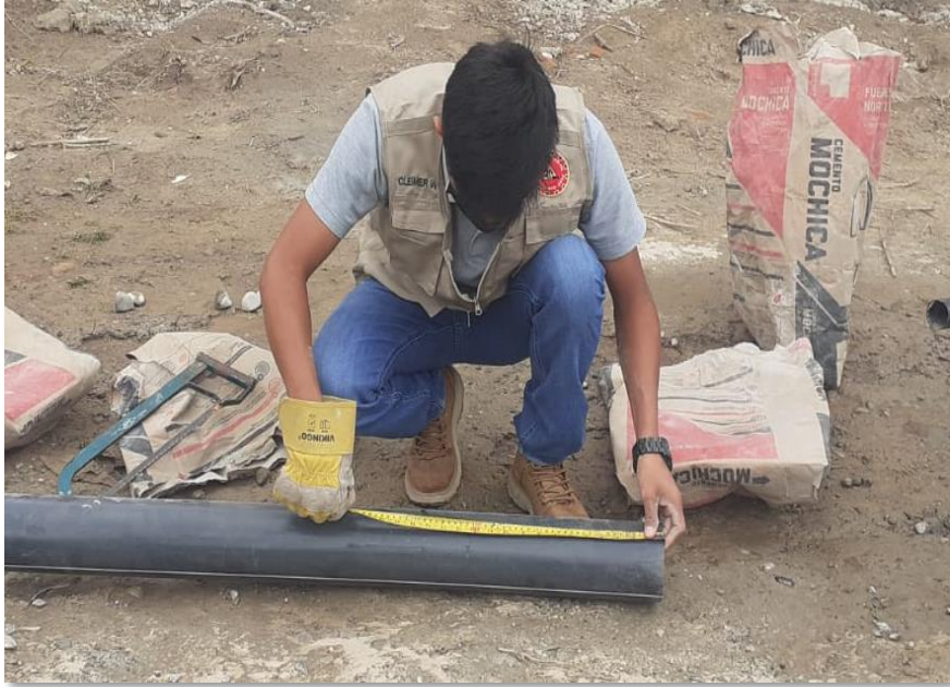
Foto 05. Medición del tubo de 4" a 50 cm de longitud
