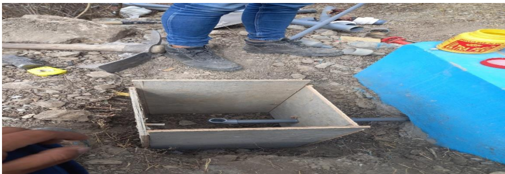
FOTOGRAFIA 3 Encofrado de caja de válvula
