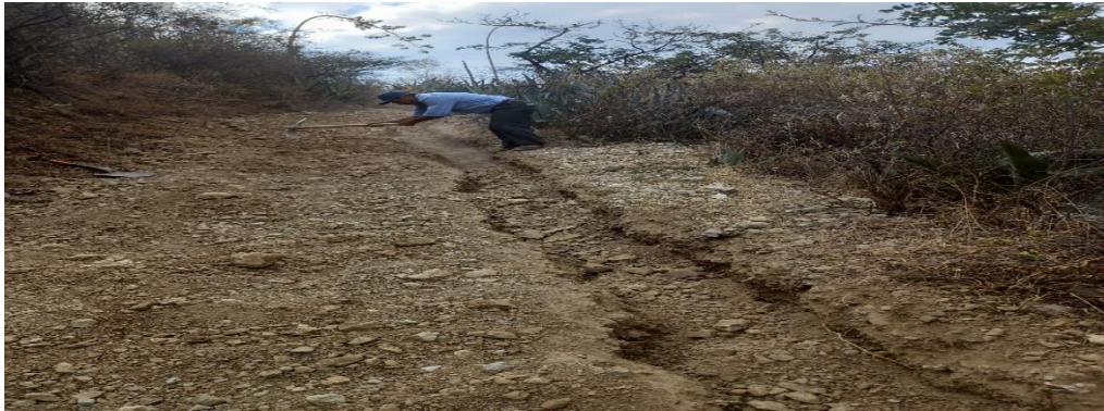
FOTOGRAFIA 1. Apertura de zanja, para tubería
