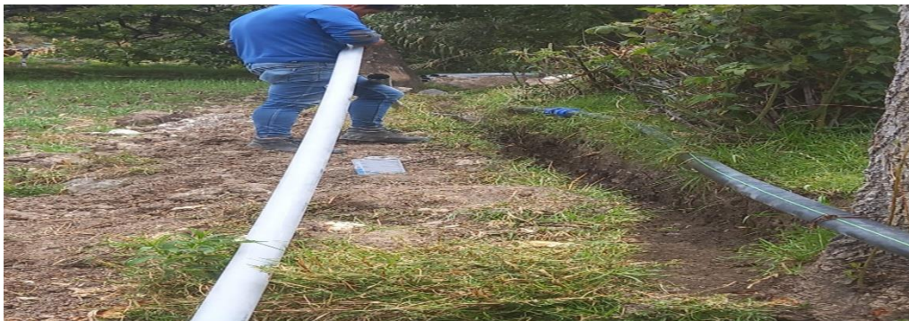
FOTOGRAFIA 2 Colocación de tubería
