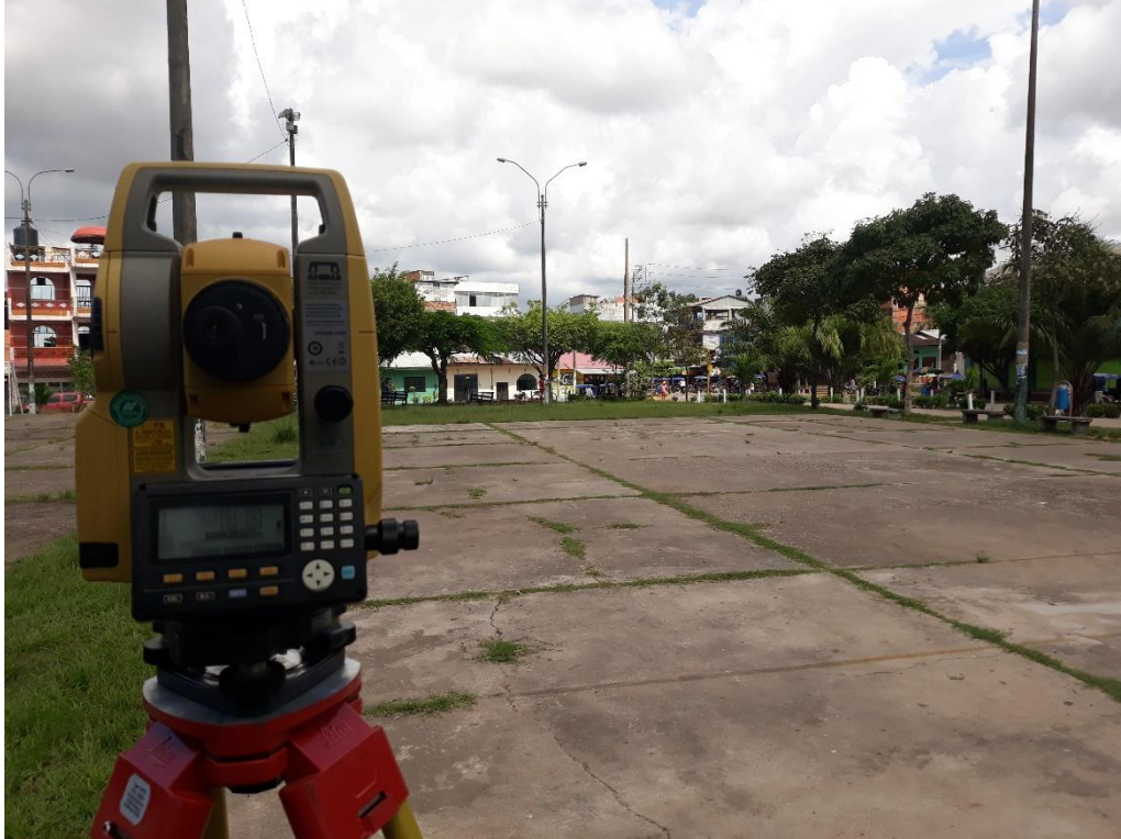
Foto N° 05: VIAS DE ACCESOS AL PARQUE DETERIORADOS
