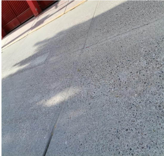
Imagen N° 13: Pulimiento de la Superficie
