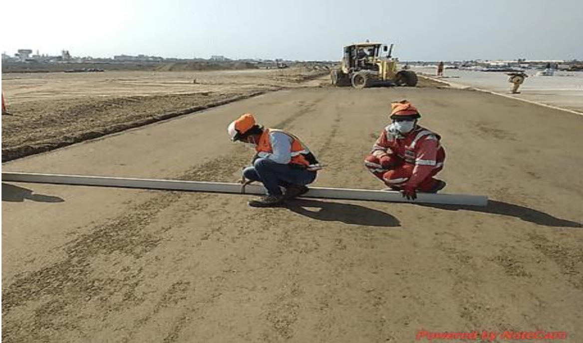
Foto 7. Liberación por lisura de base granular en margen izquierdo de la pista principal.
