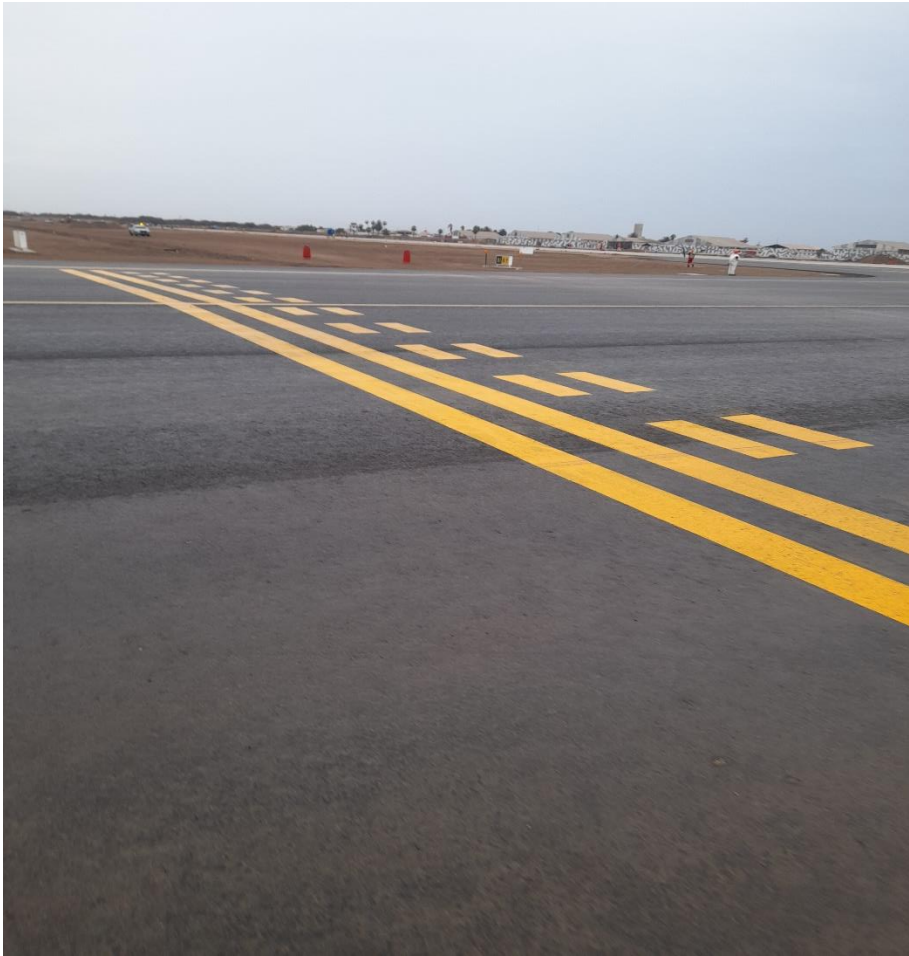
Foto 10. Señalización de pase
