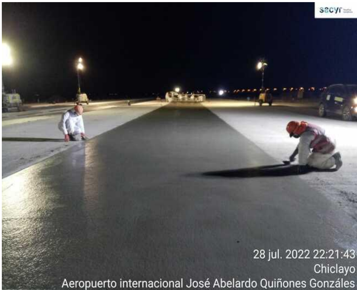
Foto 5. Vaciado de concreto F'C= 420 en la faja X-8
