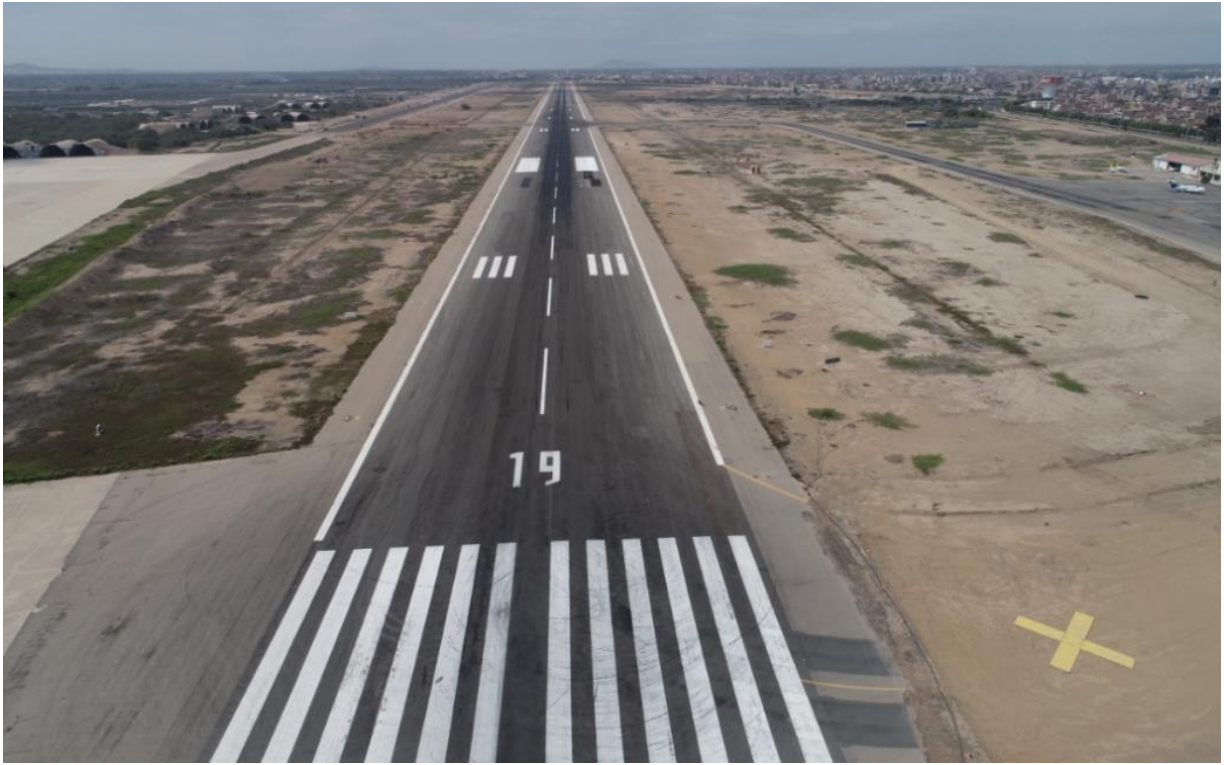
Foto 11. Terminado de la pista
