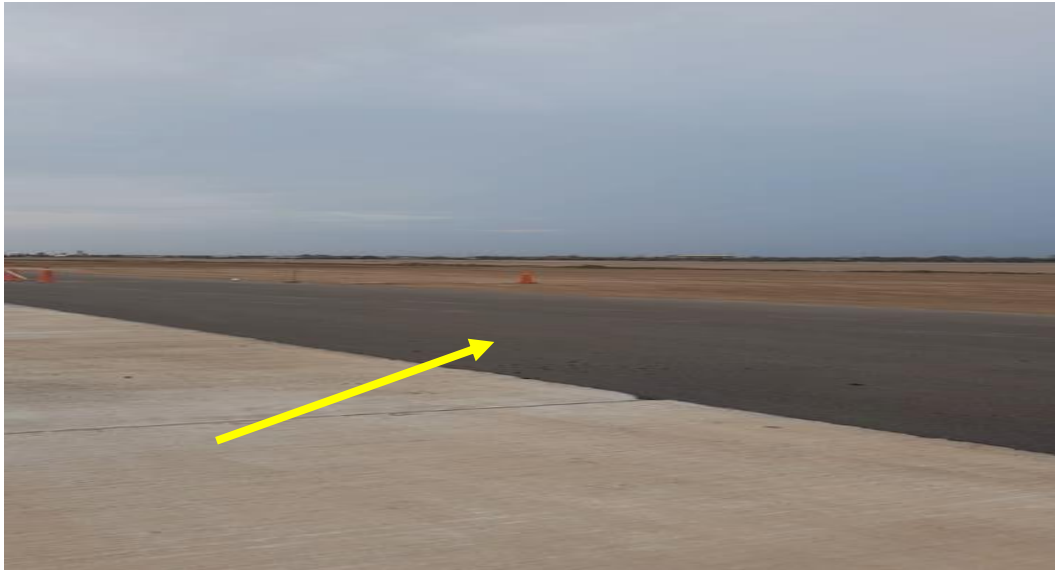
Foto 8. Terminado final de resa
