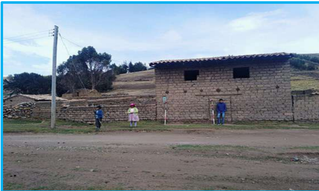
fotografía 4 Zona en donde se empalmara a la red existente.
