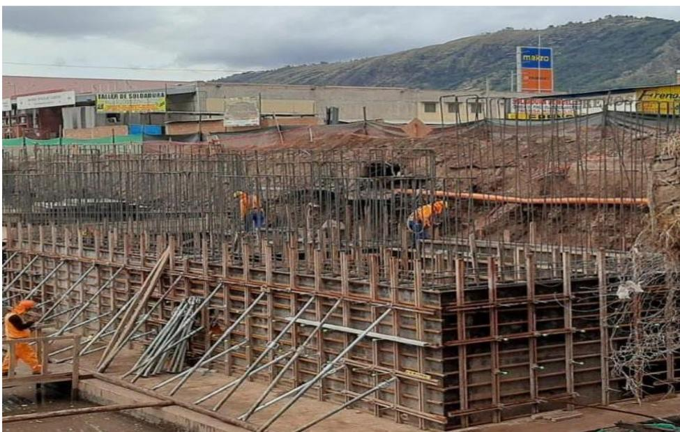
**Fotografía 3 Inspección de plataforma de trabajo para el vertido de concreto**
