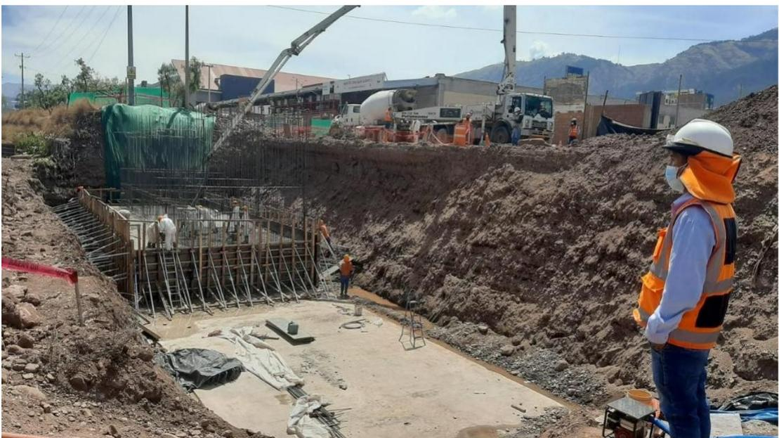
**Fotografía 6 vaciado zapata 01**
