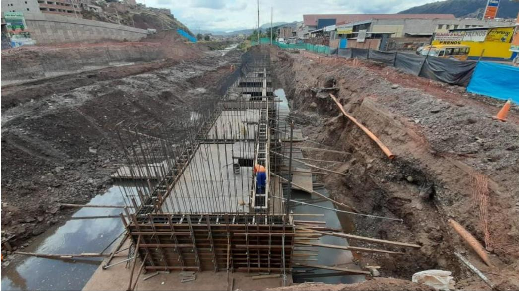
**Fotografía 4 Encofrado de muro pantalla, contrafuerte y fondeo de viga**
