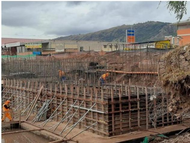
**Ilustración 5** *Distribución de largueros en altura del muro*
