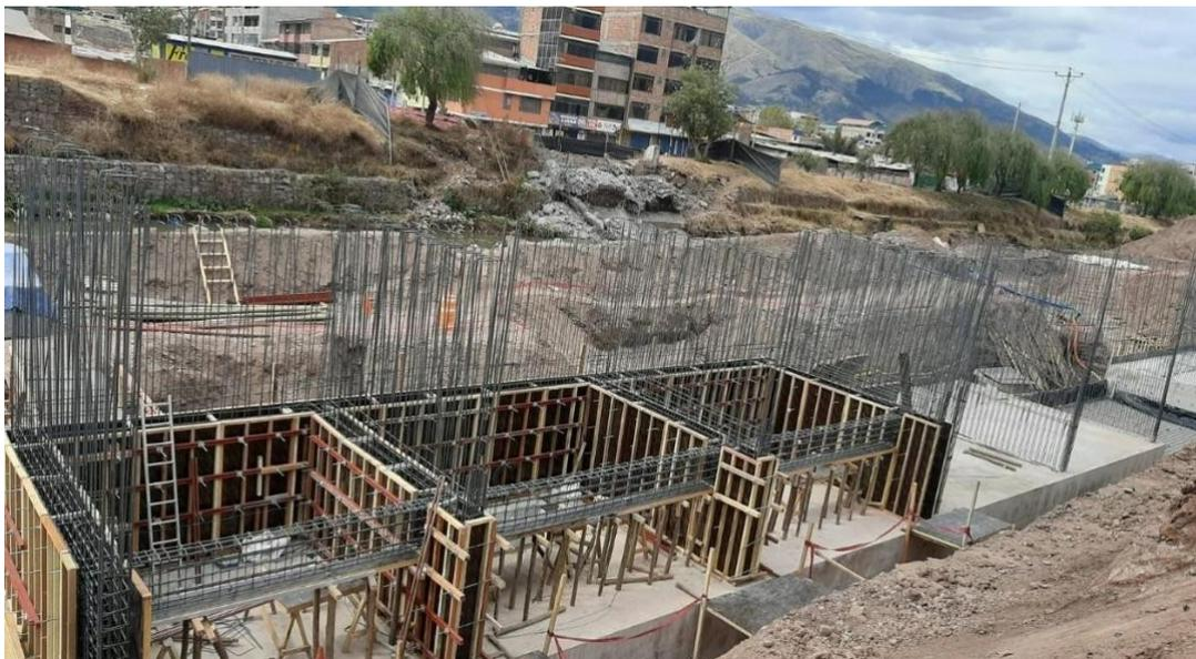
**Fotografía 5 Encofrado muro (pantalla y contrafuerte) tramo 01**
