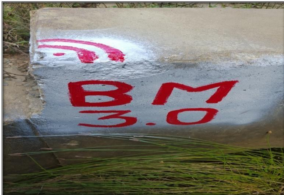
pintado sobre muro de ALC. Y rocas fijas(BMs)
