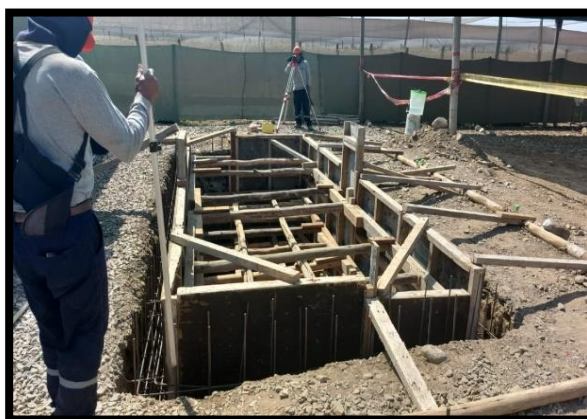
Imagen 3: ENCOFRADOS.
