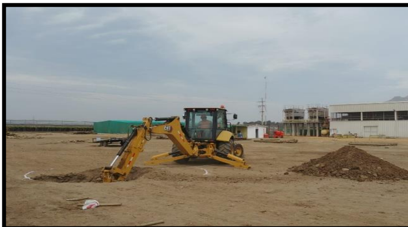
Imagen 2: EXCAVACION DE ZANJAS.
