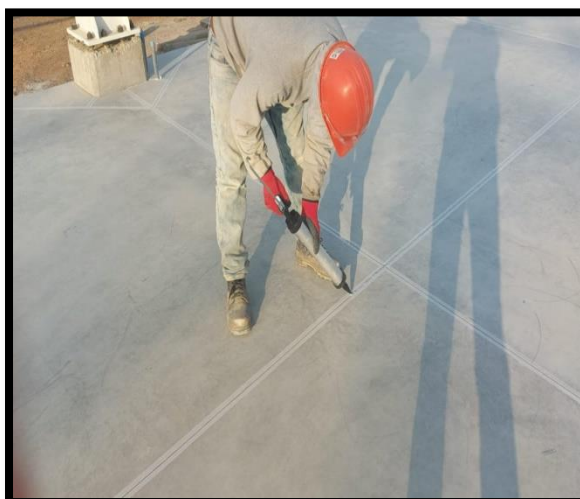
Imagen 7: CORTE Y SELLADO DE JUNTAS.
