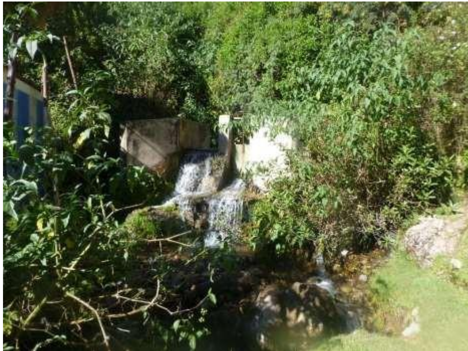
Figura 04: Ubicación de la captación
