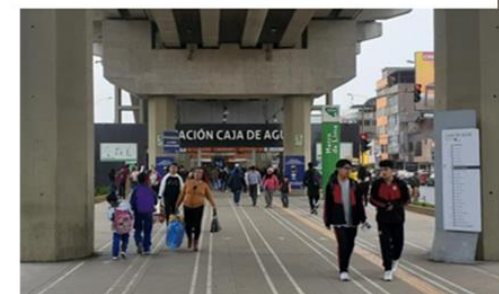
Vista 6: Ingreso principal a la Estación Caja de Agua.
