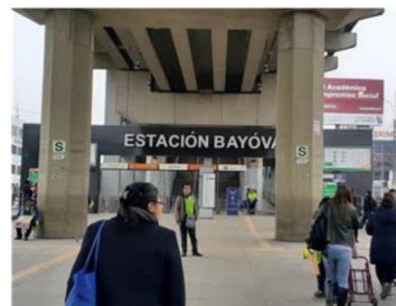
Vista 6 , Ingreso principal a la Estación Bayóvar.
