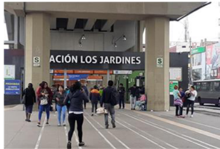
Vista 6, Ingreso principal a la Estación Los Jardines.
