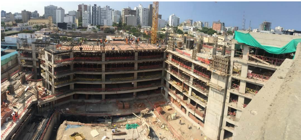
VACIADO LOSA 4P-S3 Y COLUMNAS 5P-S2
