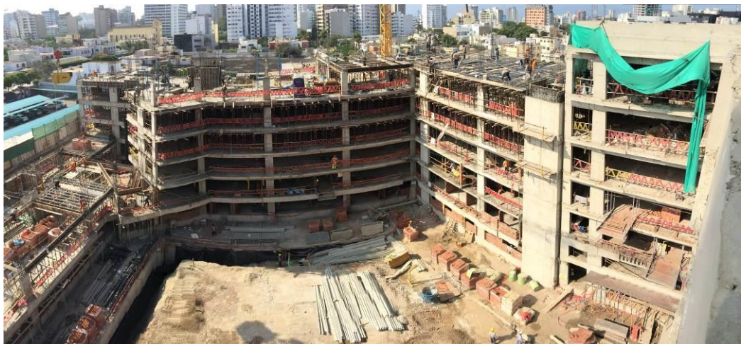
VACIADO LOSA 4P-S5 Y COLUMNAS 5P-S3/4
