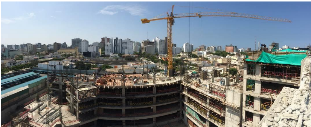
VACIADO LOSA 3P-S3 Y COLUMNAS 4P-S2
