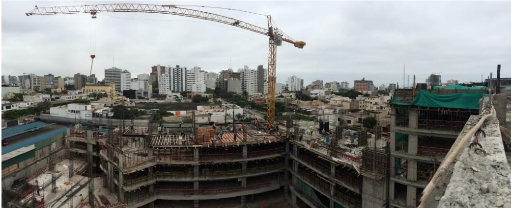
VACIADO LOSA 3P-S2 Y COLUMNAS 4P-S1
