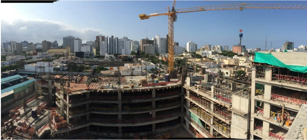
VACIADO LOSA 3P-S3 Y COLUMNAS 4P-S2
