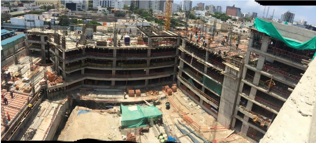
VACIADO LOSA 3P-S5 Y COLUMNAS 4P-S4
