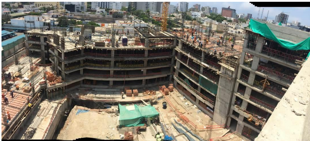
VACIADO LOSA 4P-S1 Y COLUMNAS 4P-S5
