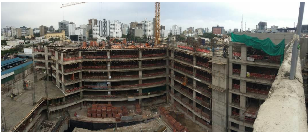
VACIADO LOSA 5P-S2 Y COLUMNAS 6P-S1
