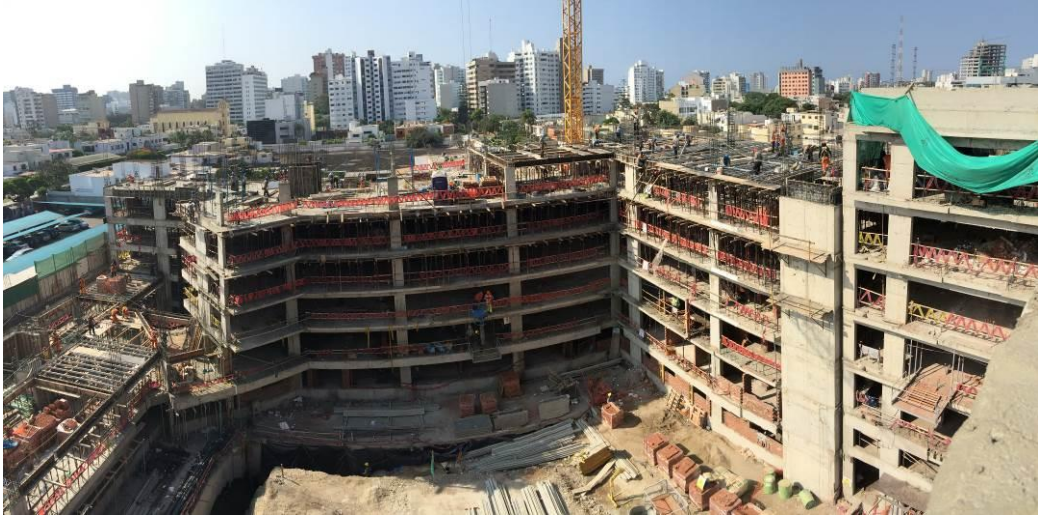
VACIADO LOSA 5P-S1 Y COLUMNAS 5P-S5
