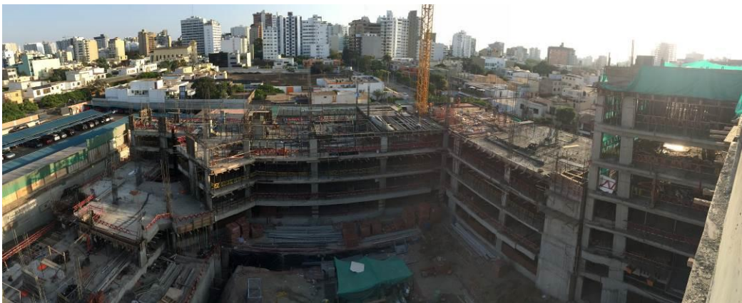
VACIADO LOSA 3P-S1 Y COLUMNAS 3P-S5
