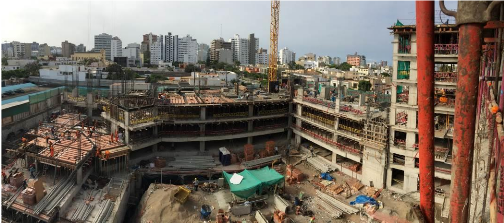
VACIADO LOSA 2P-S3 Y COLUMNAS 3P-S2
