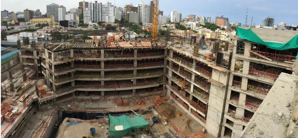
VACIADO LOSA 4P-S2 Y COLUMNAS 5P-S1
