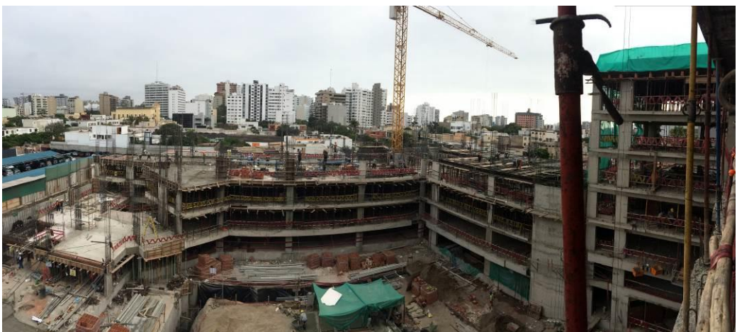
VACIADO LOSA 2P-S5/S4 Y COLUMNAS 3P-S3/4
