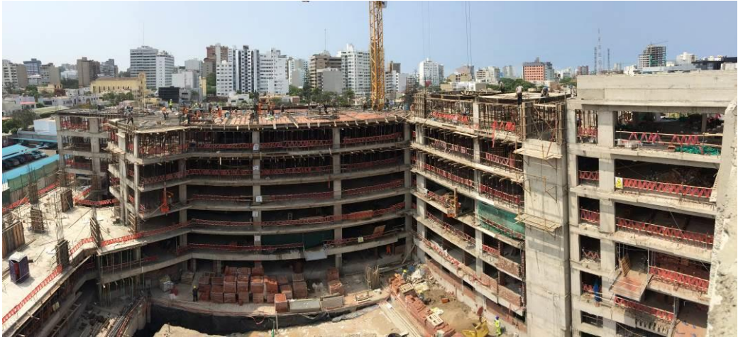
VACIADO LOSA 5P-S3 Y COLUMNAS 6P-S2
