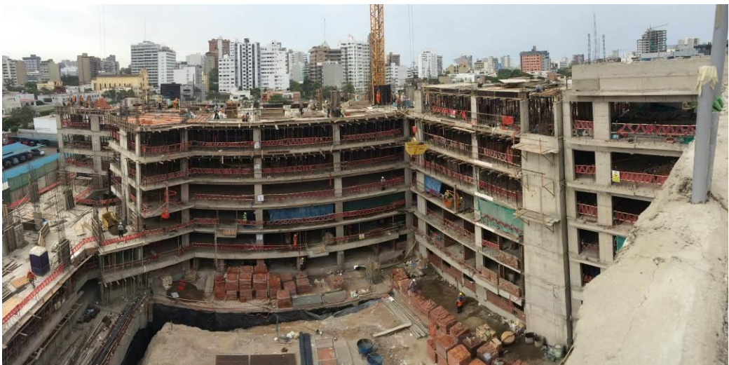
VACIADO LOSA 5P-S4 Y COLUMNAS 6P-S3
