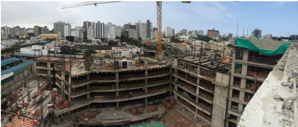
VACIADO LOSA 3P-S4 Y COLUMNAS 4P-S3
