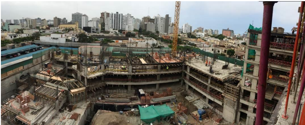
VACIADO LOSA 2P-S2 Y COLUMNAS 3P-S1
