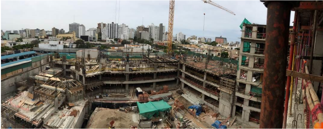
VACIADO LOSA 2P-S1 Y COLUMNAS 2P-S5
