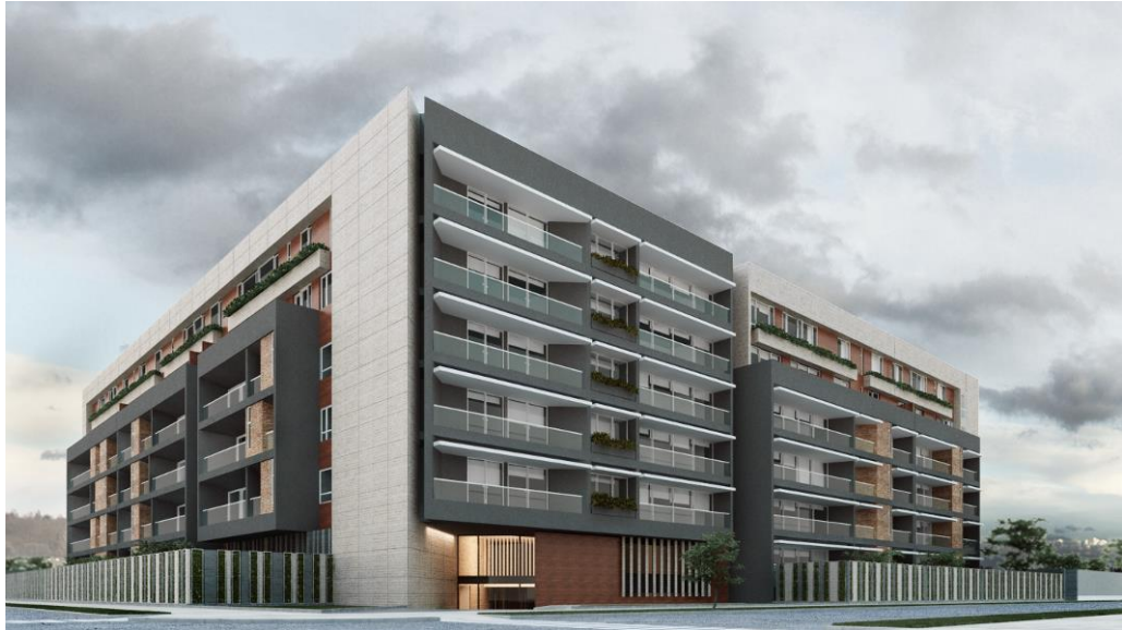
Imagen 3D del proyecto / Fuente: Inmobiliaria Volterra
