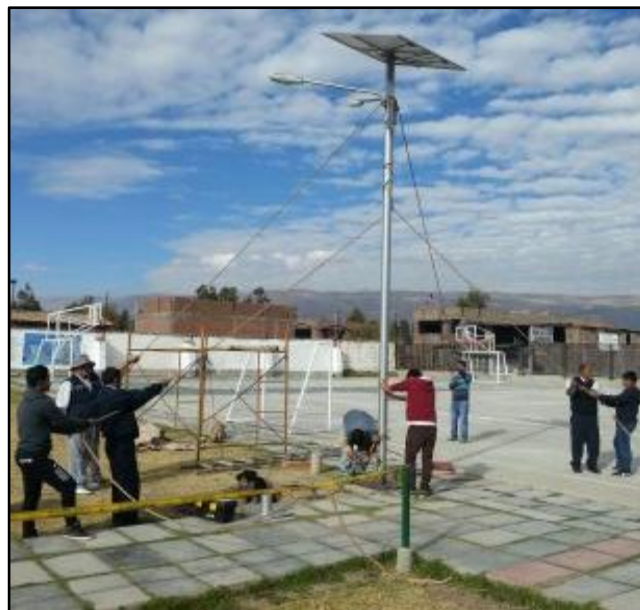
Figura 81: Instalación de los componentes en el poste solar
