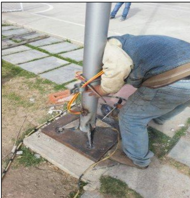
Foto 01: Fijación de la base del poste solar en la instalación fotovoltaica
