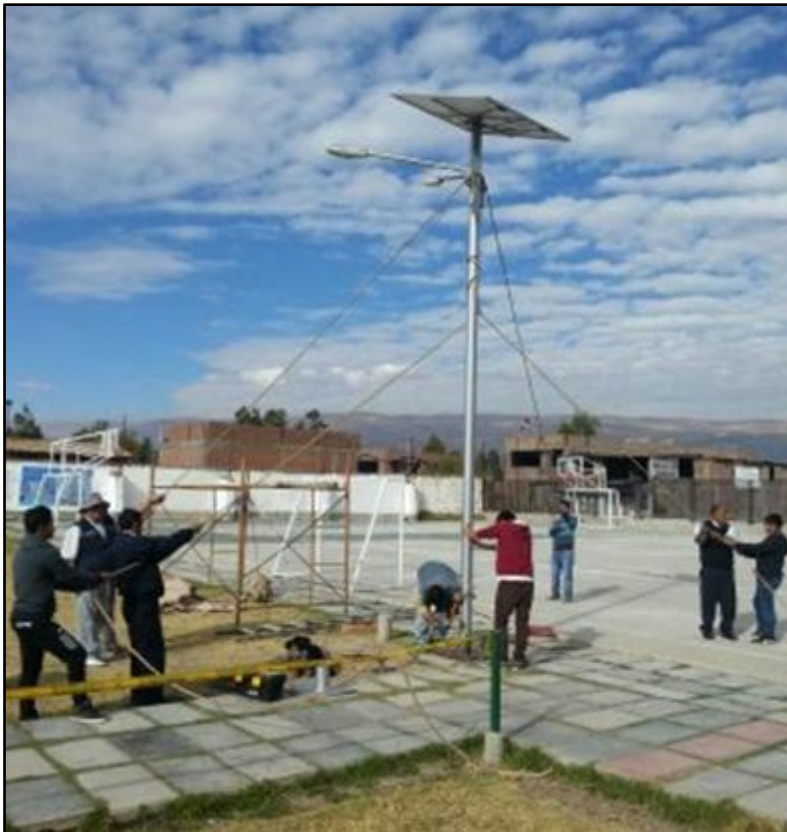
Foto 01: Control de calidad del soporte con el equipo instalado
