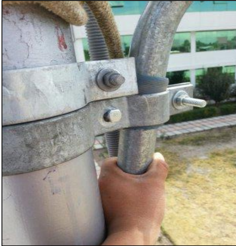
Foto 01: pruebas de sujeción de las abrazaderas del poste solar en la instalación fotovoltaica
