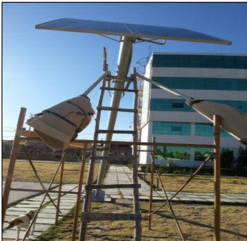
Foto 01: Instalación del poste solar en la UAP-Filial Huancayo
