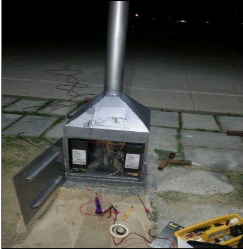
Foto 01: instalación de los componentes acumuladores en la base de poste solar
