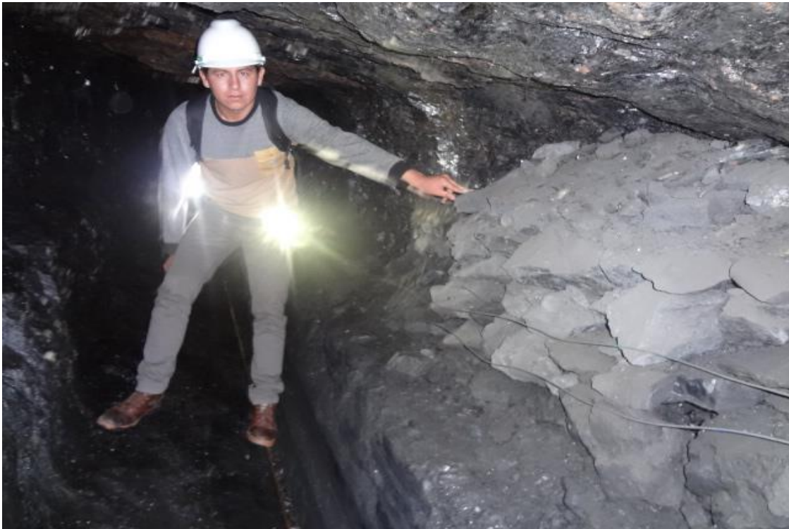
Figura 52. Sostenimiento. Fuente: Elaboración propia, 2017.
