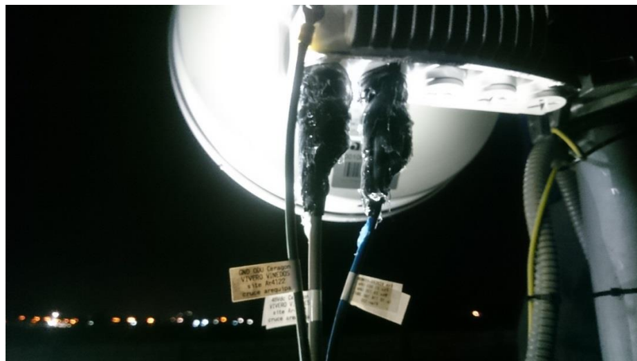
Foto 17: Vista de conexiones a ODU, etiquetado, engrasado de pernería.
