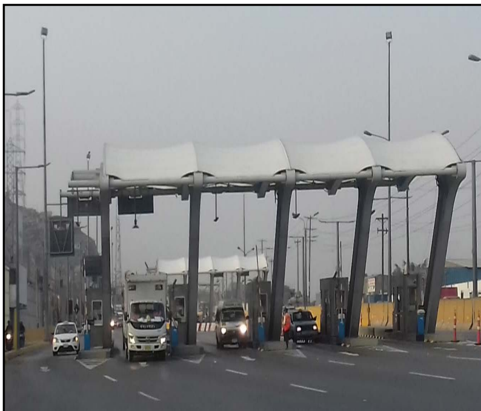
Figura 34 Peaje Chillón Automatizado sin Congestión vehicular
