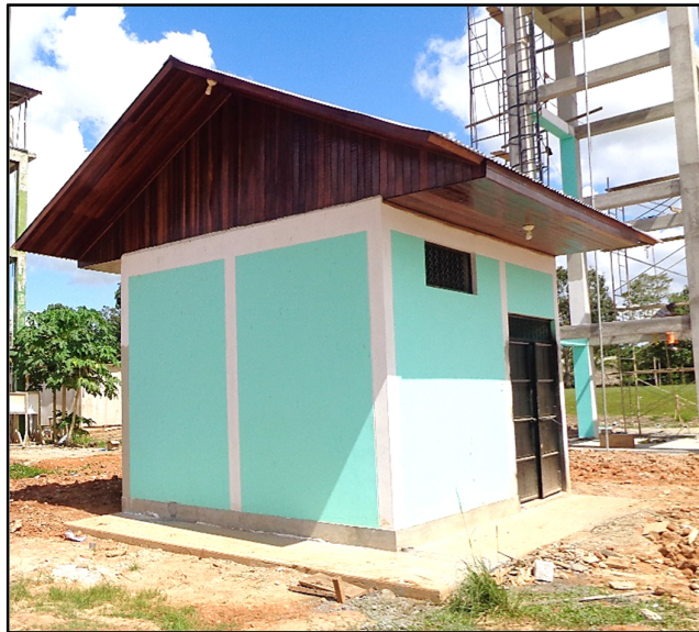
IMAGEN N° 06: CASETA DE VÁLVULAS Y ALMACEN DE CLORO.
