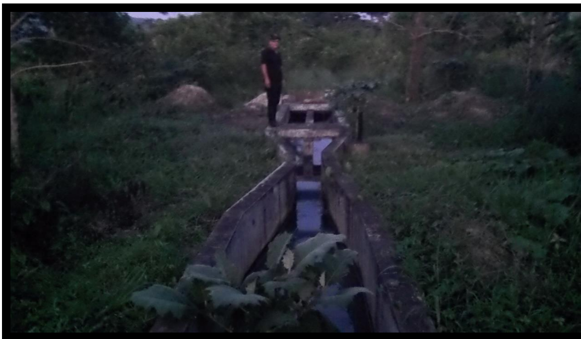
IMAGEN 04: Reconocimiento de las instalaciones (Canal de parshall)
