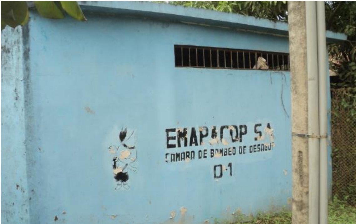
Imagen 14: Vista de la Cámara de Bombeo de Desagüe Existente N°01.
