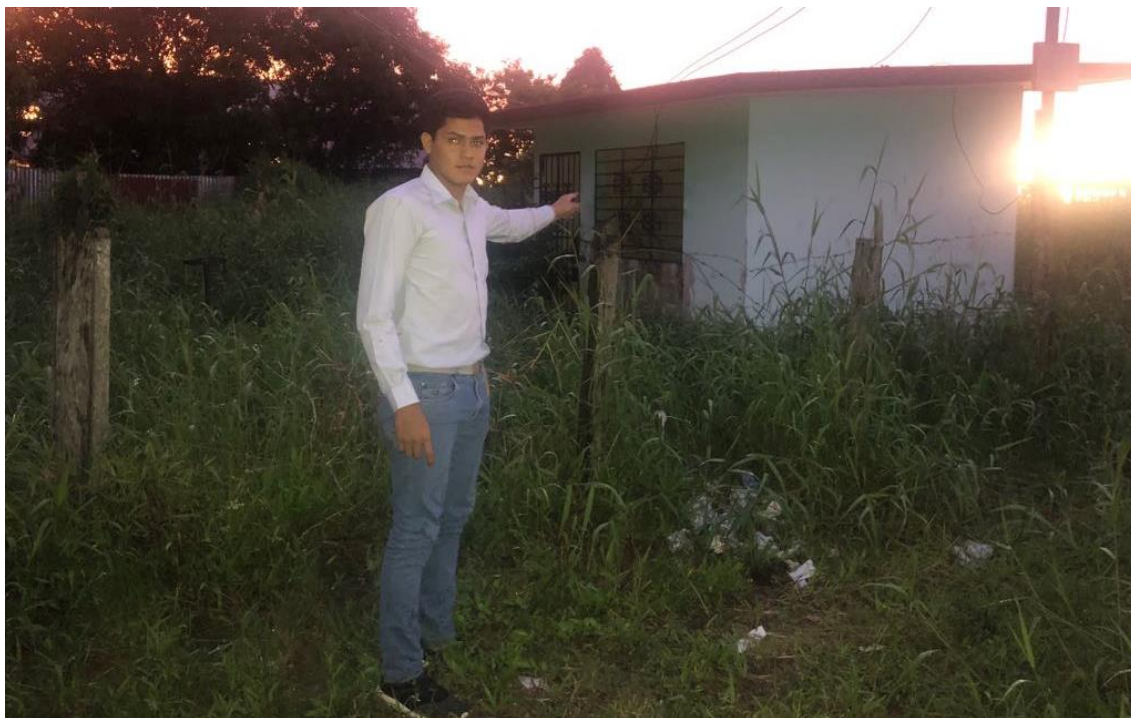
Imagen 18: Vista de la Cámara de Bombeo de Desagüe Existente N°02.
