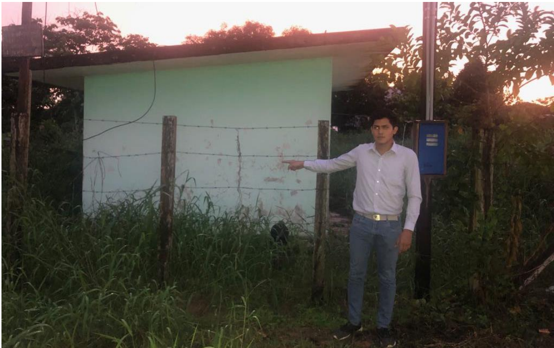
Imagen 15: Vista de la Cámara de Bombeo de Desagüe Existente N°01.
