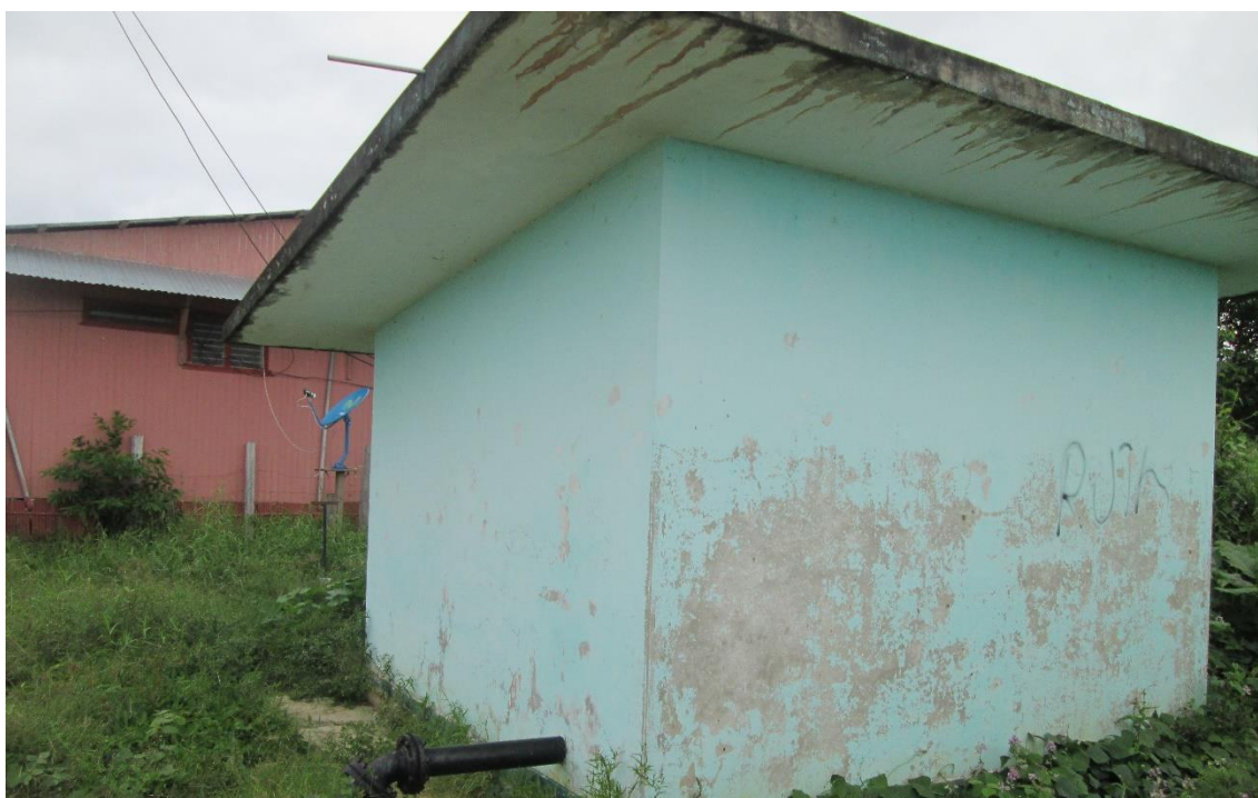
Imagen 17: Vista de la Cámara de Bombeo de Desagüe Existente N°02.
