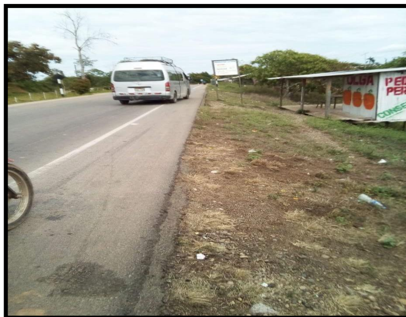
Foto N° 12: Vista Carretera Federico Basadre
