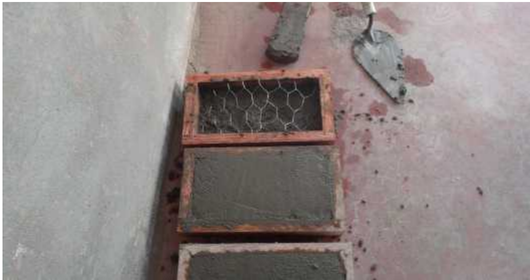
FOTO 6.- PREPARACIÓN DE LOS VACIADOS DE FERROCEMENTO
