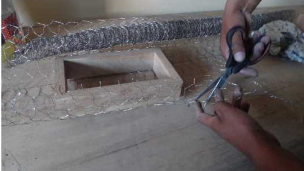
FOTO 5.- PREPARACIÓN DEL REFUERZO (MALLA GALLINERO)
