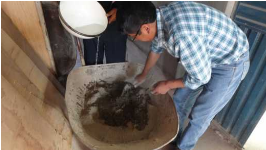
FOTO 4.- PREPARACIÓN DEL MORTERO
