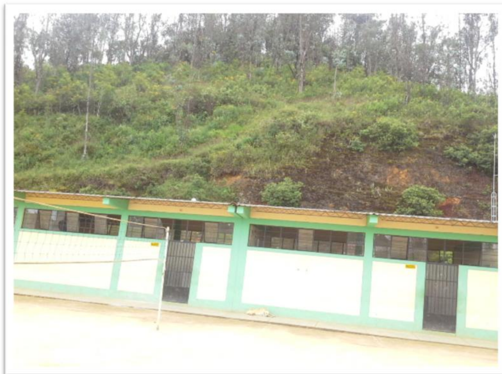
Aulas de un pabellón de la I.E. “San Fernando” - Chalaco
