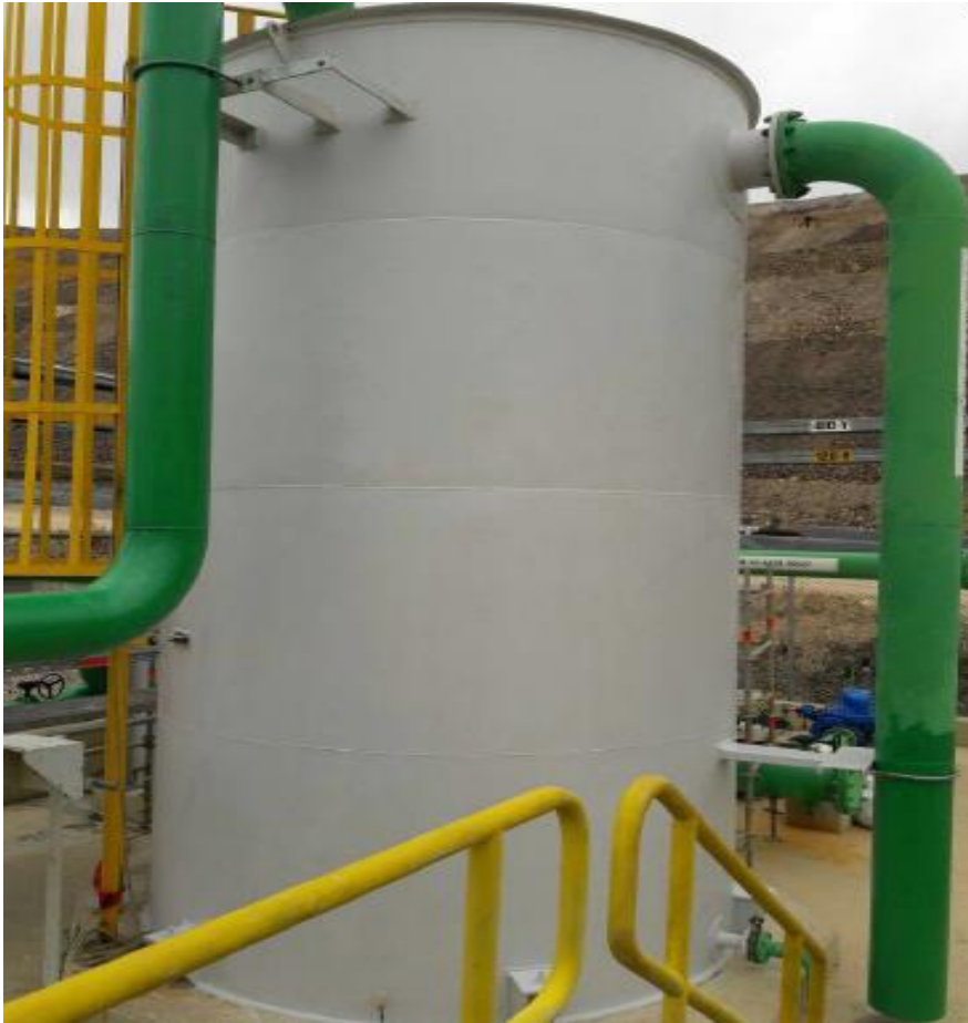
Figura 3.3.7 Tanque Pulmón terminado con mayor capacidad
