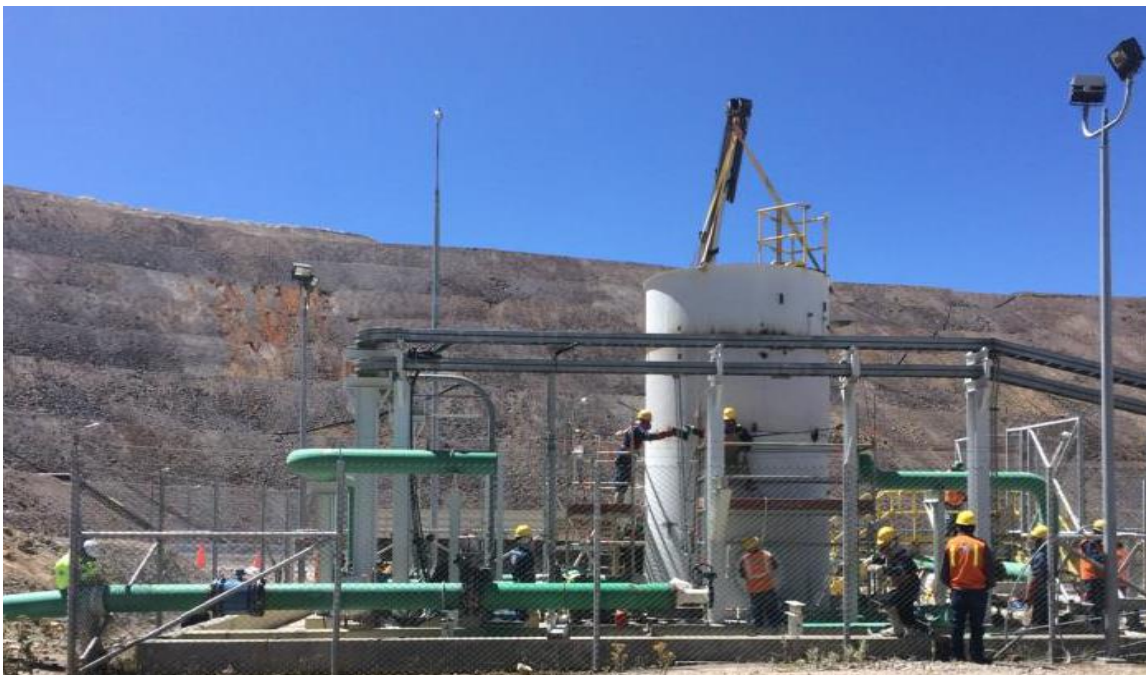
Figura 3.3.6 Instalación de un anillo metálico adicional en tanque pulmón. Fuente: Informe de cálculo de estación de re bombeo de Minera Yanacocha
