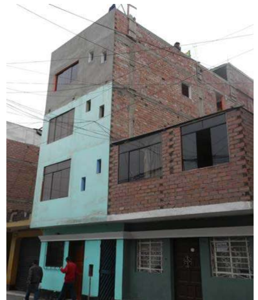
Foto 4: Ampliaciones de viviendas sin licencia de Construcción. - Elaboración propia
