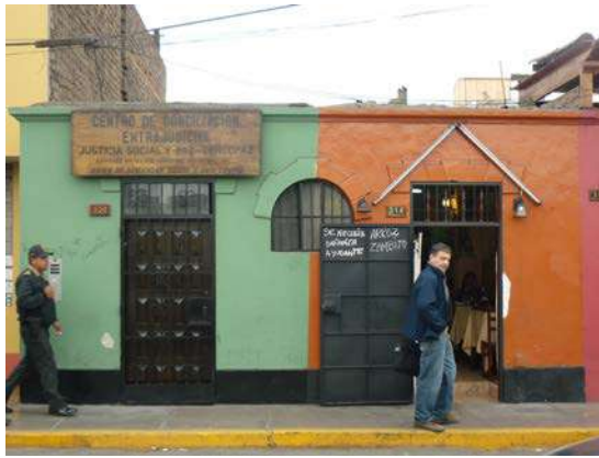
Foto 5: Inadecuado diseño de los espacios comerciales - Elaboración propia
