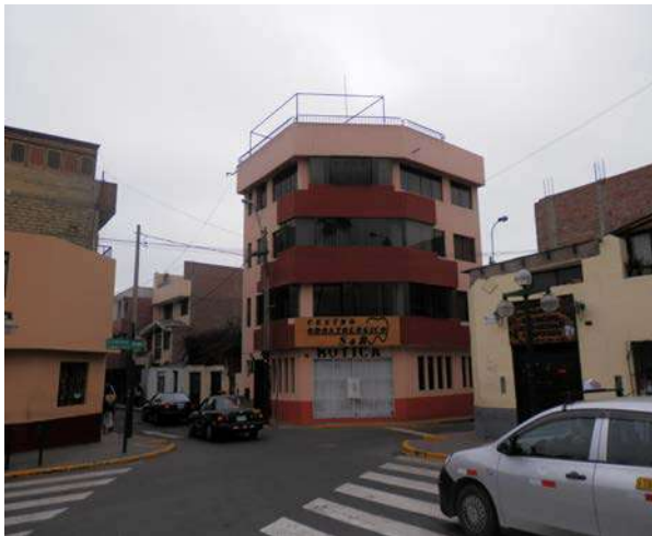
Foto 3: Ampliaciones de viviendas, en áreas no permitidas. - Elaboración propia
