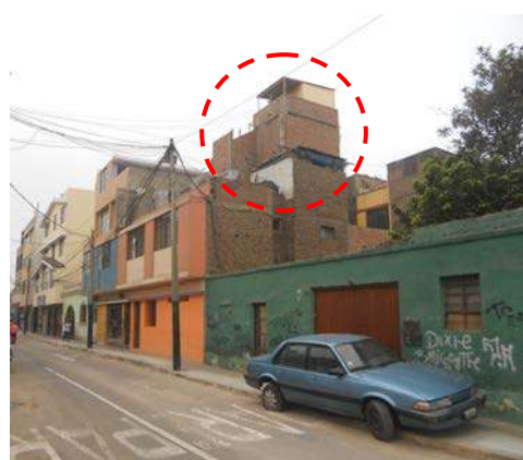
Foto 1: Ampliaciones de viviendas sin licencia de Construcción. - Elaboración propia
