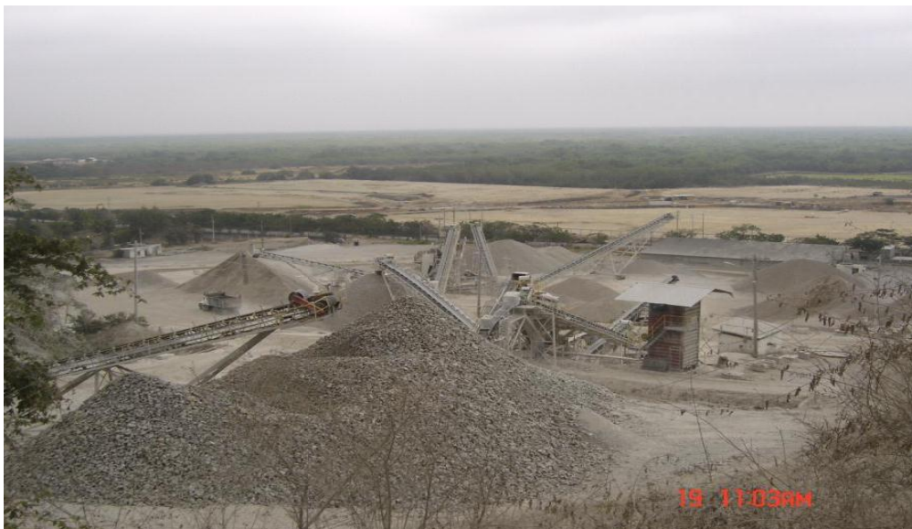
FIGURA 3.FOTO DE LA PLANTA INDUSTRIAL DE 350 TPH
