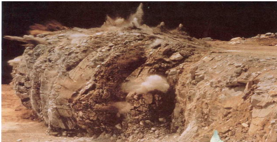
FIGURA 2. FOTO DE UNA VOLADURA
