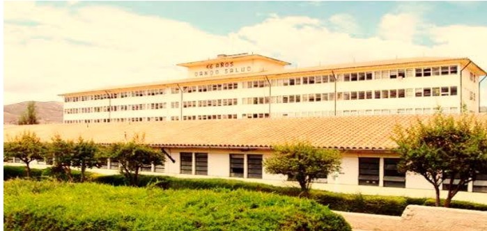
figura n° 1. Hospital Regional del Cusco
