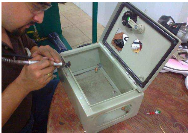
GRÁFICO N° 29 ADECUACIÓN DE TABLERO ELÉCTRICO
