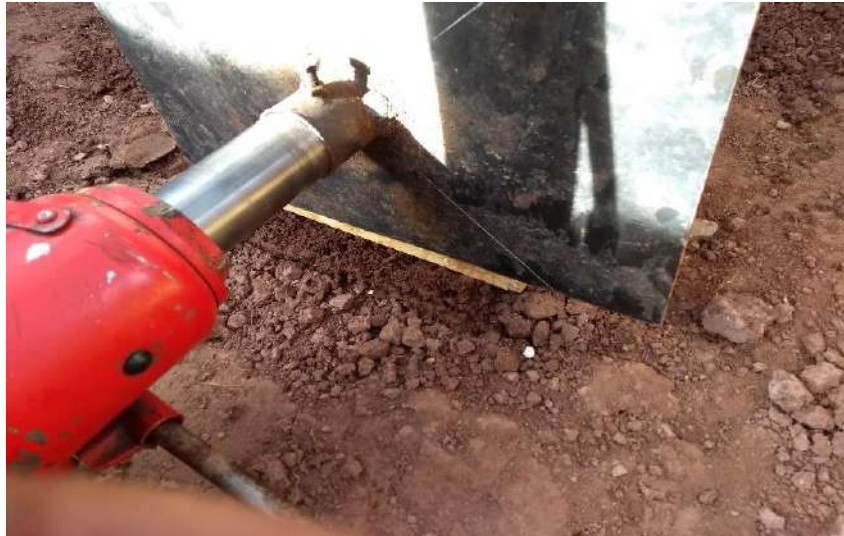
FOTOGRAFÍA 7: Lectura de la deformación horizontal del equipo.
