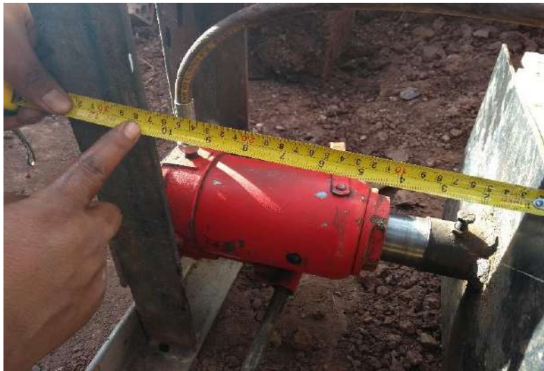
FOTOGRAFÍA 5: Lectura de la deformación horizontal del equipo.
