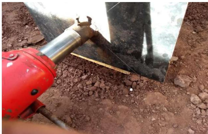
Figura N° 19: Colocación de la gata hidráulica.
