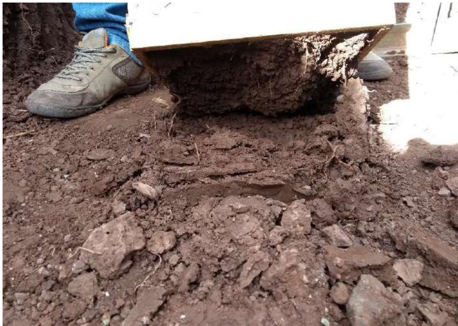
FOTOGRAFÍA 8: Lectura de la deformación horizontal del equipo.
