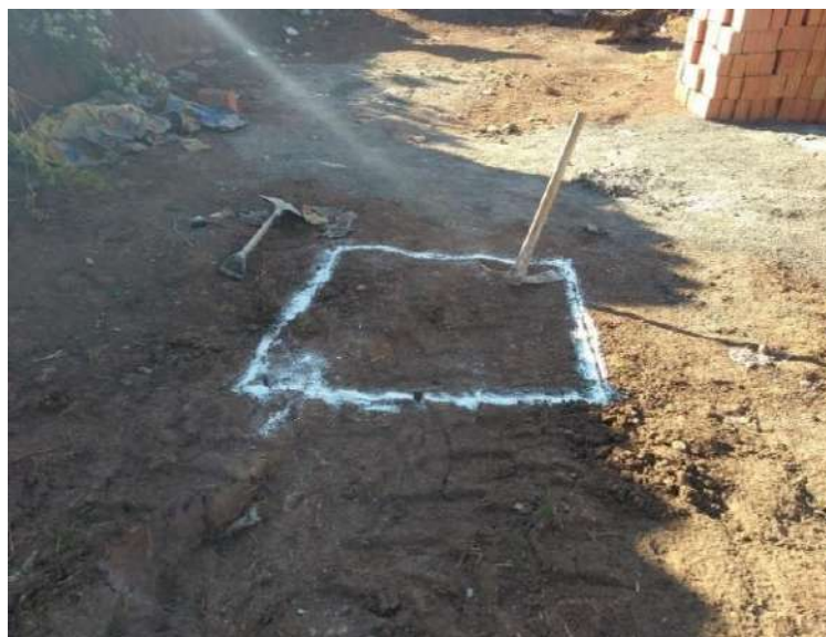
Figura 29: Trazo y excavación
