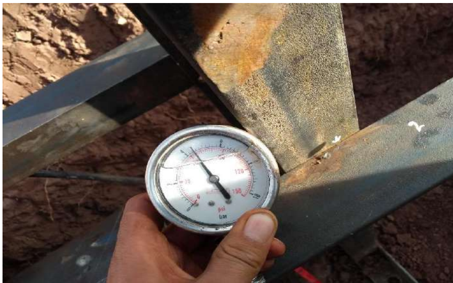
FOTOGRAFÍA 6: Lectura de la deformación horizontal del equipo.
