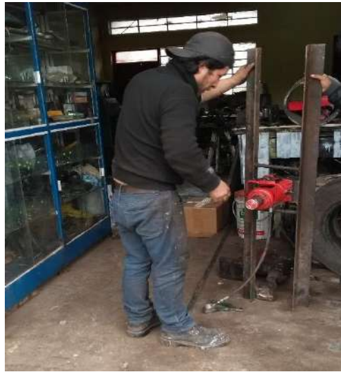
FOTOGRAFÍA 1: Preparación y adaptación del equipo in situ.
