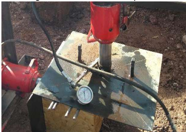
Figura 30: Colocación de los polines.
