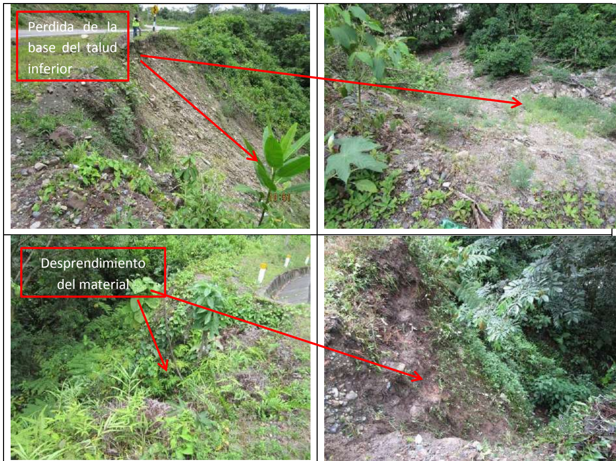
Figura. 19 Desplazamiento del Talud inferior, Agrietamiento en plataforma y pérdida del pie del talud inferior
