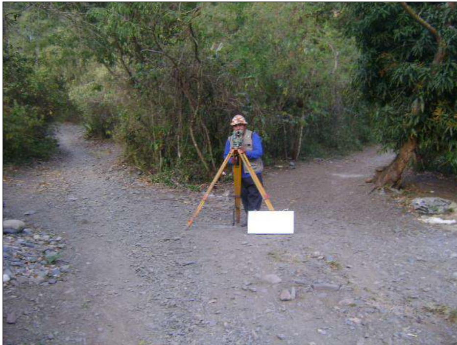
Fotografía N° 10: Km. 00+200, Trabajos de levantamiento topográfico en el sector de Manahuañunca
