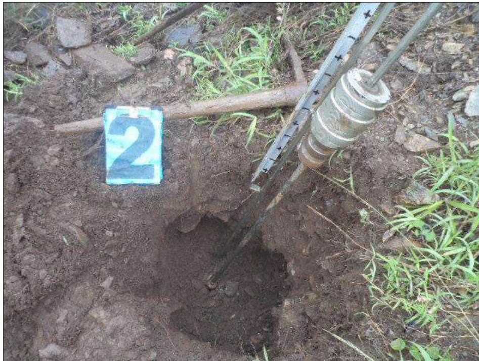
Fotografía N° 23: Calicata N° 02, Vista del ensayo con el equipo Penetrómetro Dinámico Ligero.
