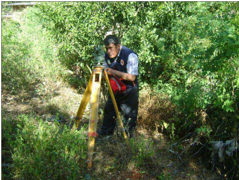
Fotografía N° 16: Km. 02+500, Levantamiento topográfico en el sector de Manahuañuncca-Limonhuayco
