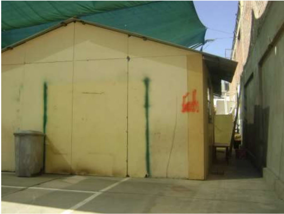
Aula prefabricada donde funciona el Taller de Educación para el Trabajo.
