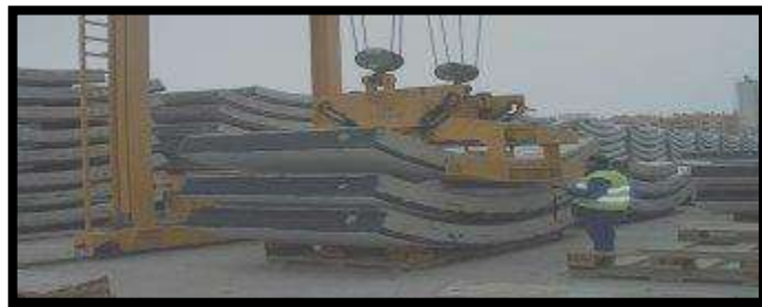
Imagen 8 Dovelas de concreto
