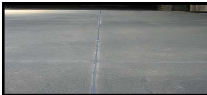
Imagen 6 Juntas de dilatación
