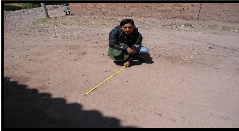
Imagen 10: Midiendo el terreno para proceder a realizar la calicata nro 1 de (1mx1mx1.50cm)
