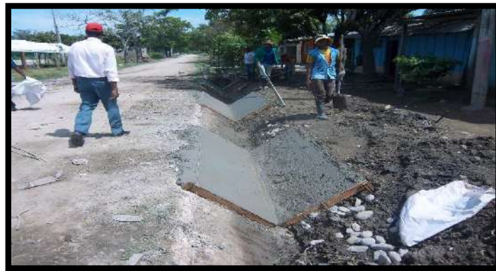
Imagen 12 Vaciado de la cuneta
