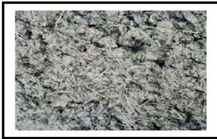
Imagen 4: Mesclado del concreto con Fibra de Acero
