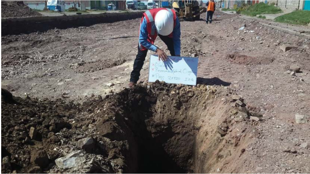
Fotografía 01: calicata para la determinación del terreno de fundación
