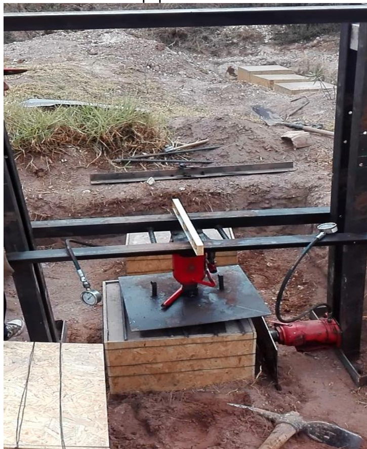
FOTOGRAFIA 5: Instalación del Equipo de Corte Insitu.
