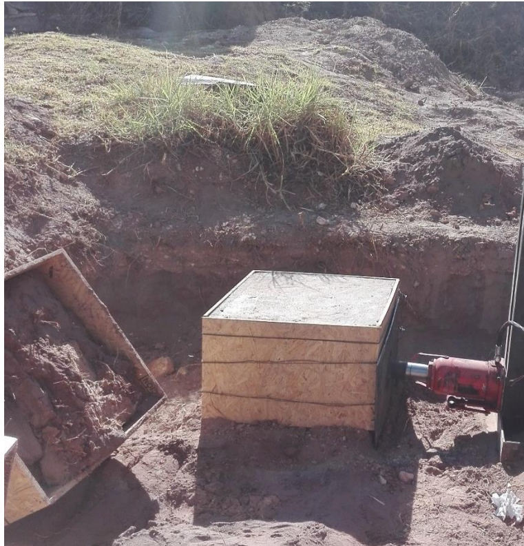
FOTOGRAFIA 8: Especímenes ensayados, mostrando falla por corte.
