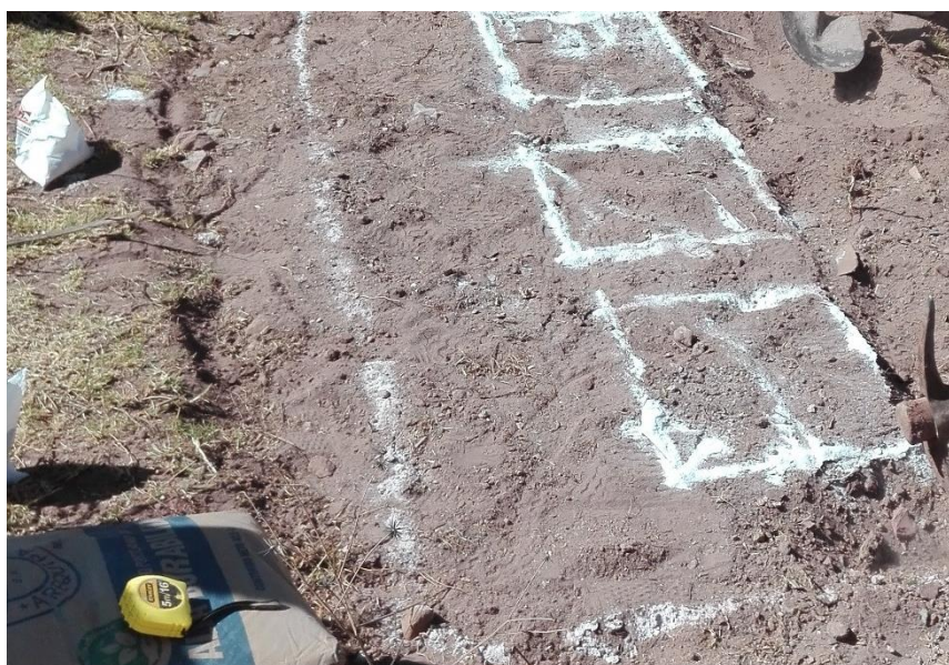
Figura N° 16: Trazo y excavación
