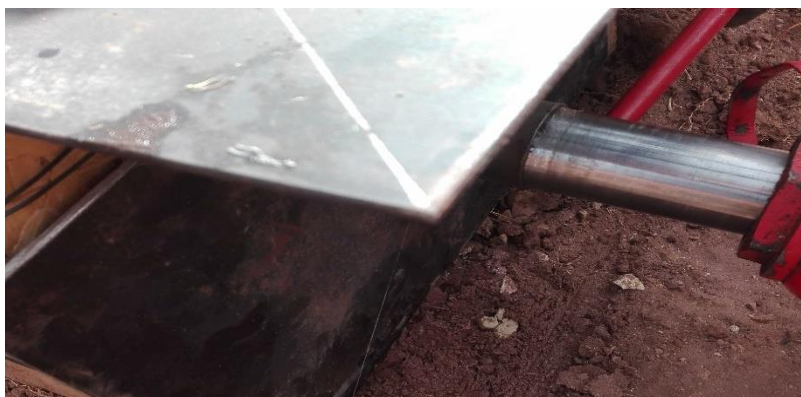
Figura N° 20: Colocación de la gata hidráulica.
