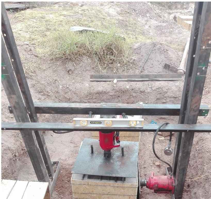
FOTOGRAFIA 6: Ejecución del ensayo en suelo natural.
