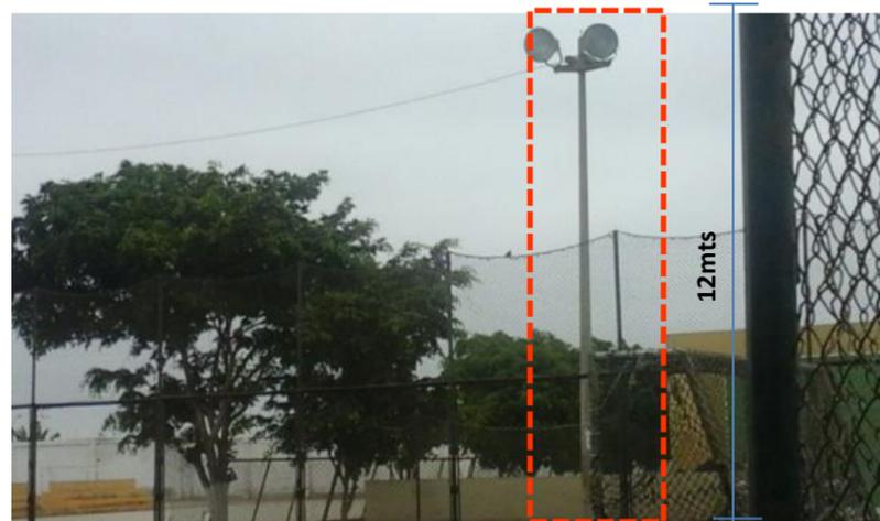
Imagen 08: Iluminación de los campos multiusos solo se aprecia una luminaria doble para 6 campos multiusos, y esta no cumple con la altura mínima de 18m establecida por la Norma.
