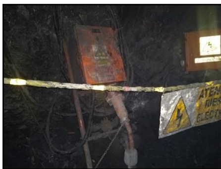
Figura 52 Conector tripolar instalado con energía
