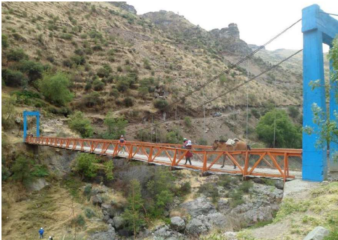
FOTOGRAFIA 06.- VISTA ZONA DEL ACCESO AL PUENTE TOTORA POR EL LADO DERECHO
