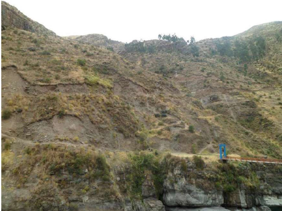
FOTOGRAFIA 5.- VISTA ZONA DEL ACCESO AL PUENTE TOTORA POR EL LADO IZQUIERDO
