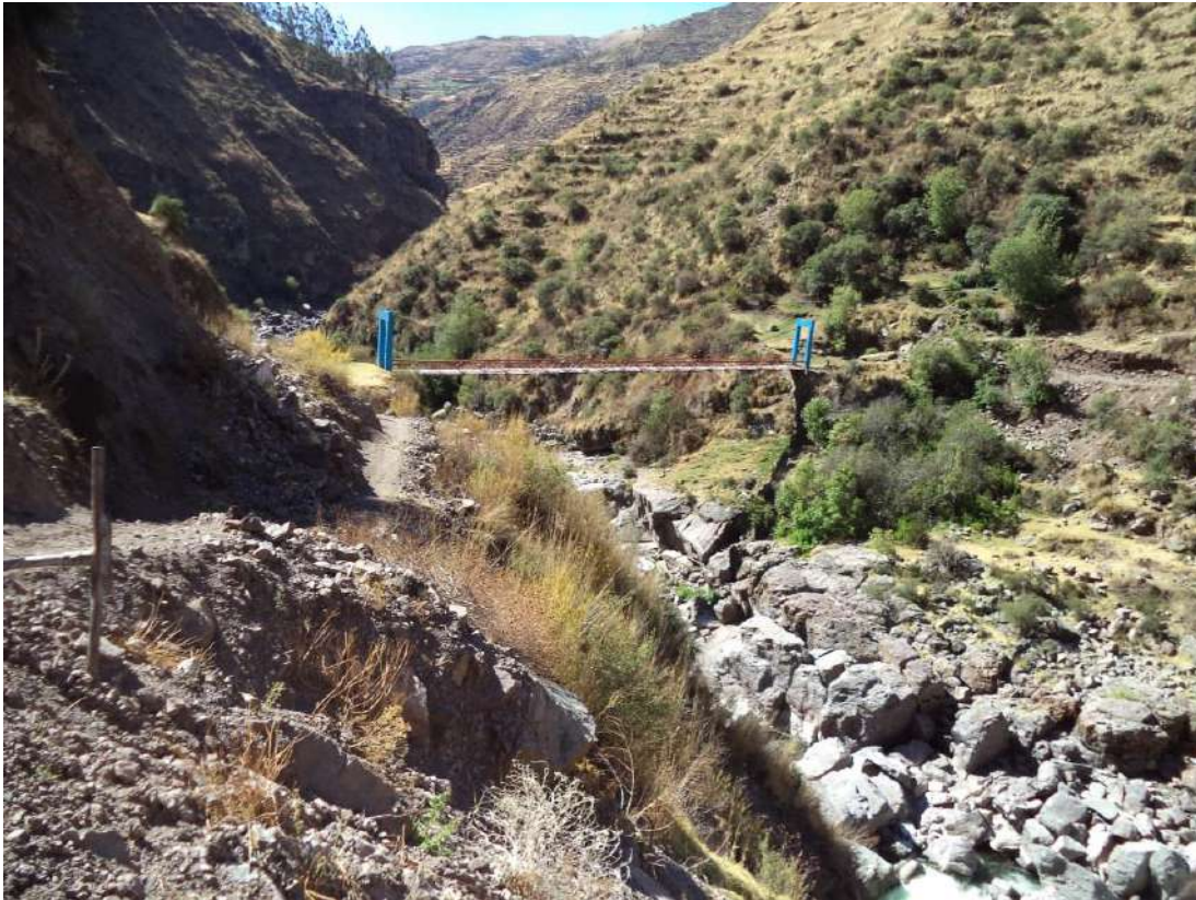
FOTOGRAFIA 1.- ZONA DE EMPLAZAMIENTO DEL PUENTE TOTORA.
