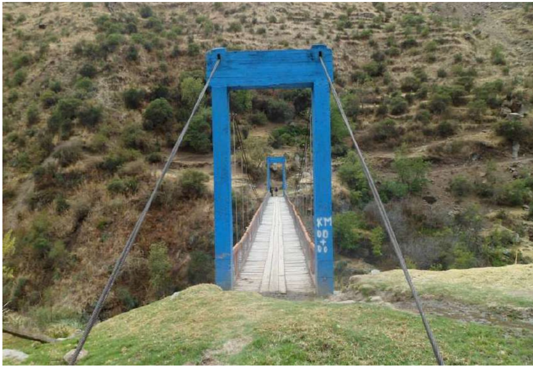
FOTOGRAFIA 07.- VISTA PUENTE PEATONAL EXISTENTE EN EL SECTOR LAMBRAPATA.
