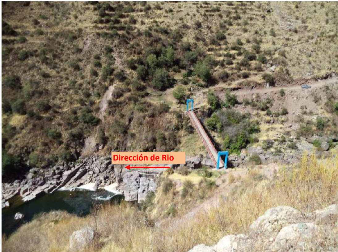
FOTOGRAFIA 08.- VISTA DEL PUENTE TOTORA, MARGEN IZQUIERDA EMPIEZA LA PROGRESIVA 00+000 KM
