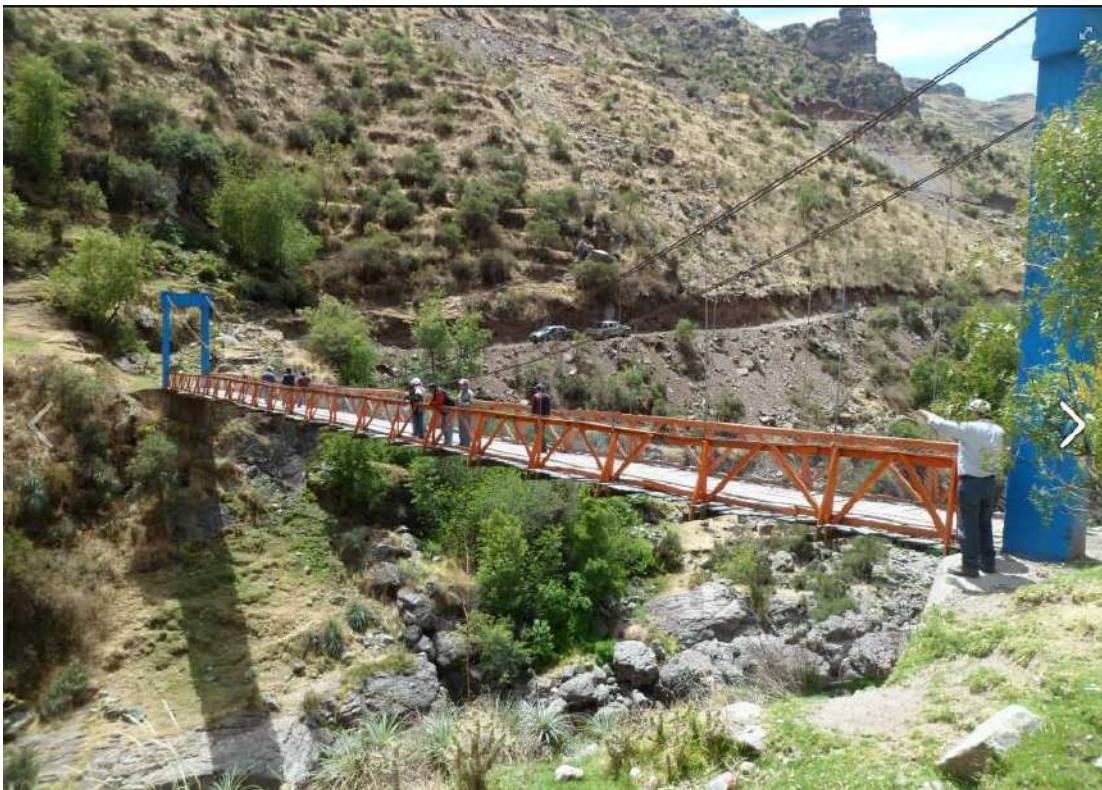
FOTOGRAFIA 2.- ZONA DE EMPLAZAMIENTO DEL ESTRIBO DERECHO
