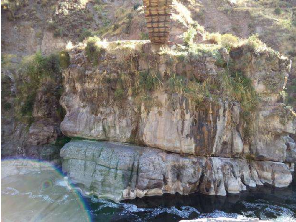
FOTOGRAFIA 09.- VISTA AREA EMPLAZAMIENTO DEL ESTRIBO MARGEN IZQUIERDA
