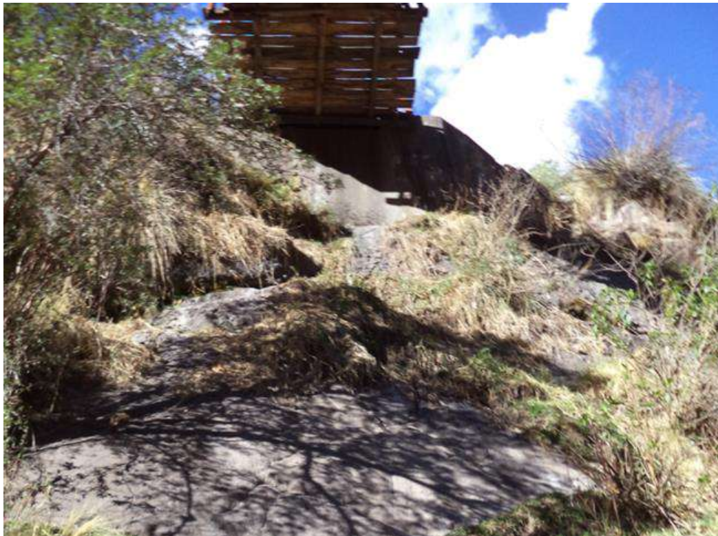
FOTOGRAFIA 10.- VISTA AREA EMPLAZAMIENTO DEL ESTRIBO MARGEN IZQUIERDA.
