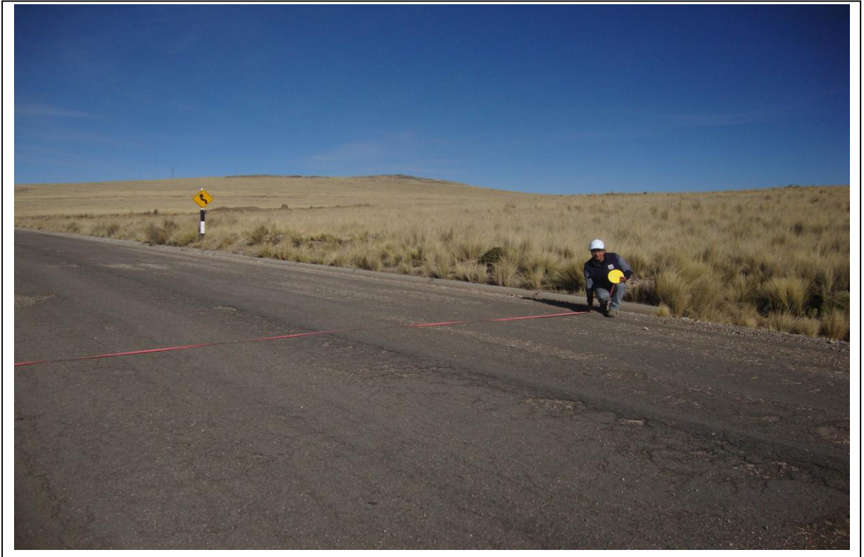
FOTOGRAFIA N° 03 CARACTERISTICAS DE LA VIA
