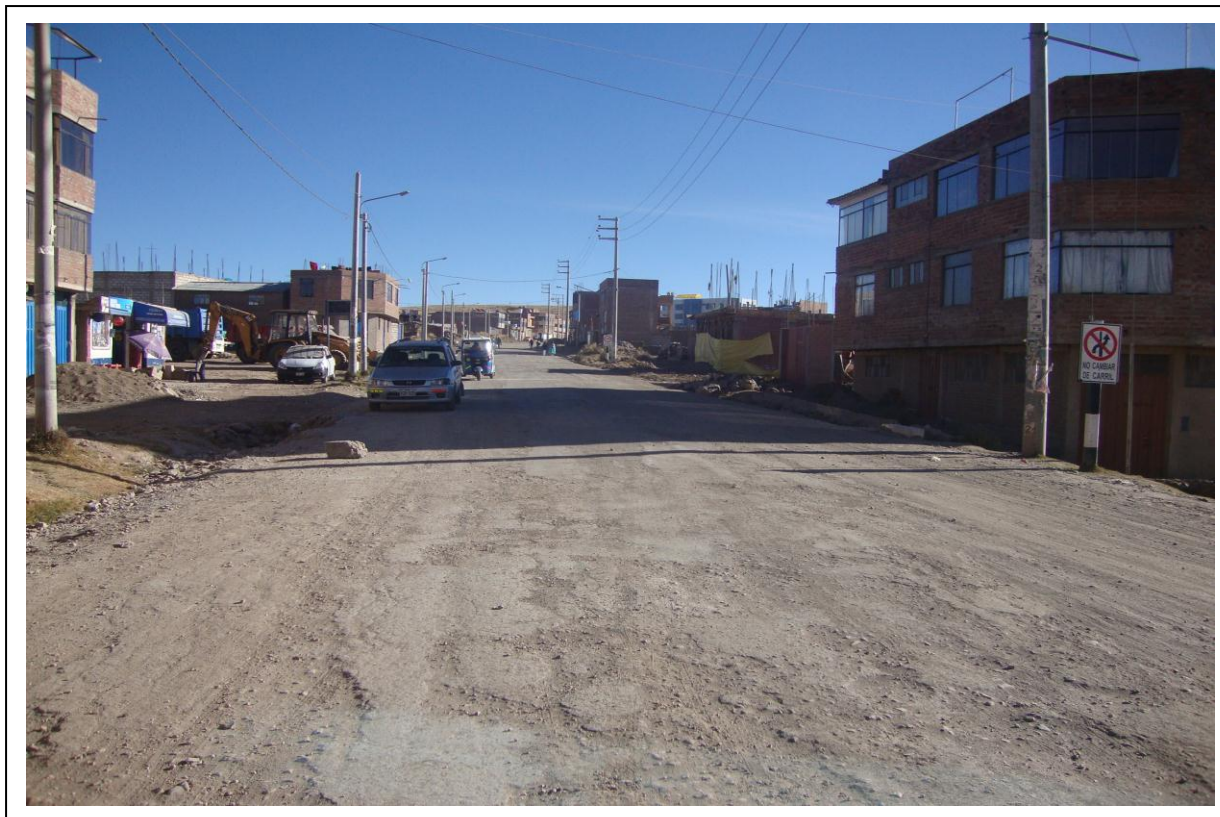
FOTOGRAFIA N° 15 ESCALONAMIENTO ENTRE CALZADA Y BERMA
