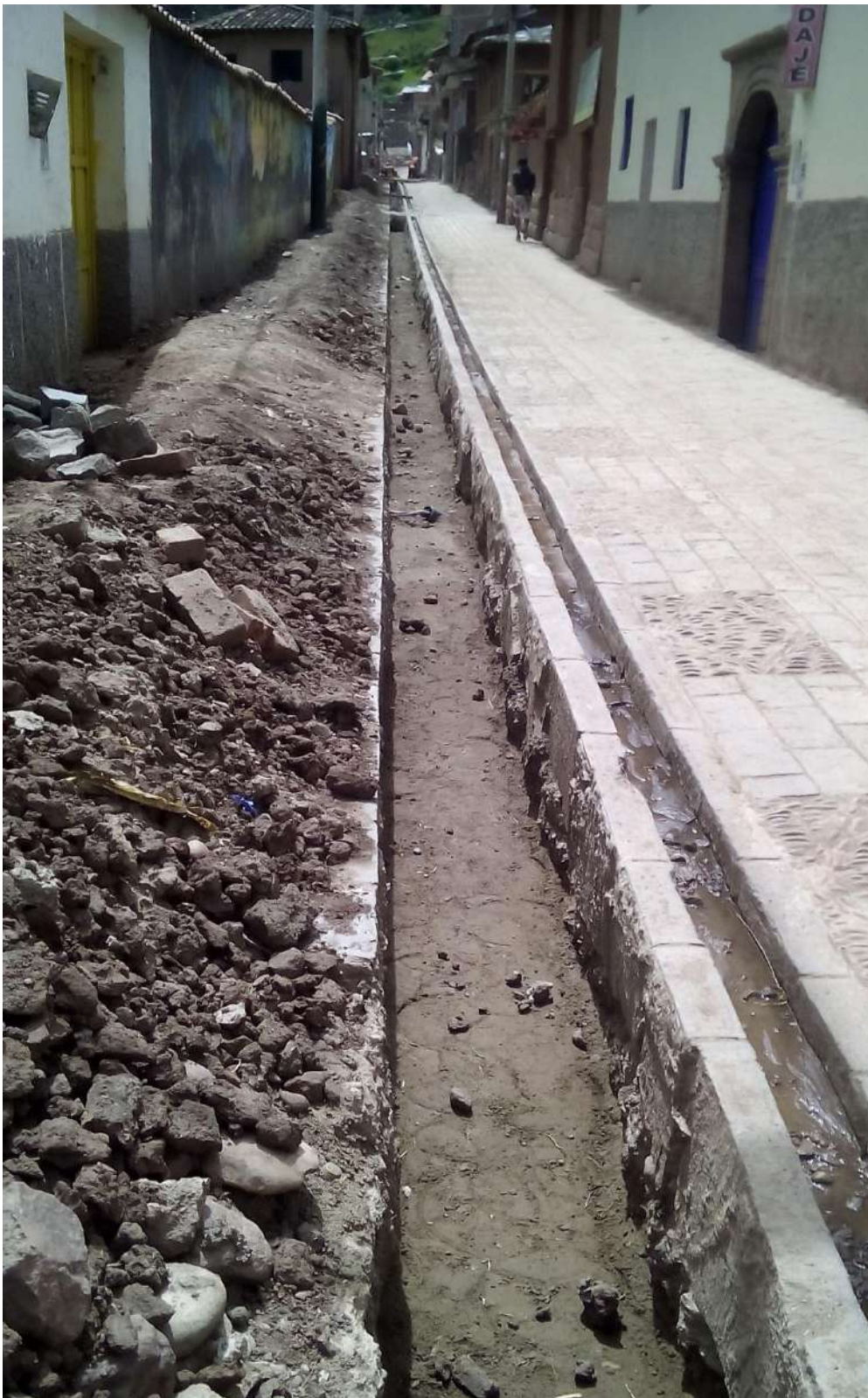
Fig. N° 16: Canal De Drenaje Existente Al Costado De La Zanja En Calle Espinar.
