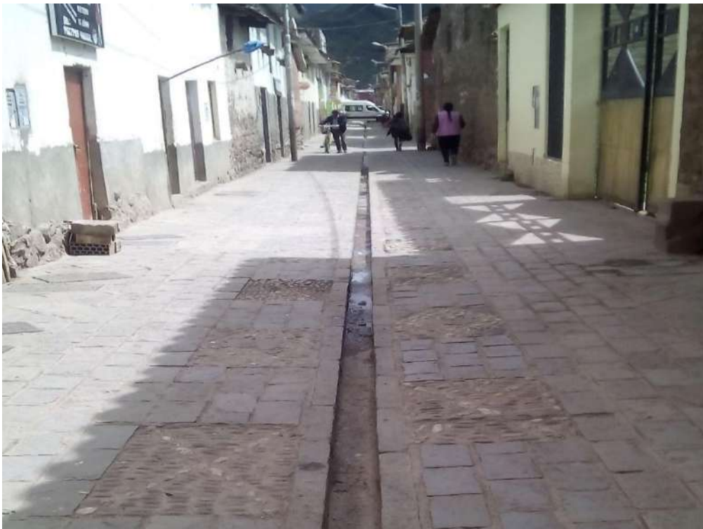
Fig. N° 15: Canal De Drenaje Existente En Calle Vigil.
