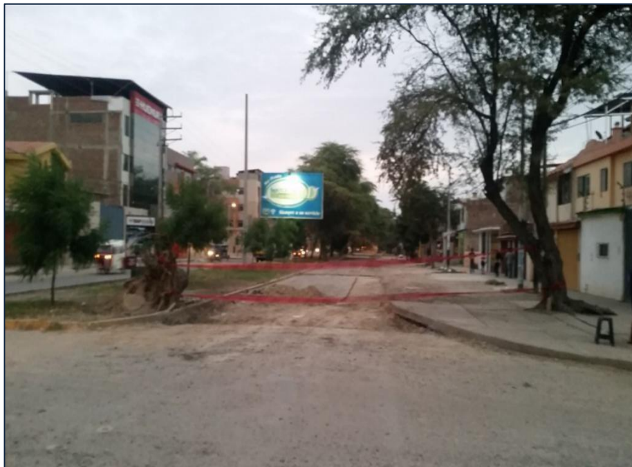
Figura 12: Av. Vice corte de secciones a rehabilitar cuadra 2
