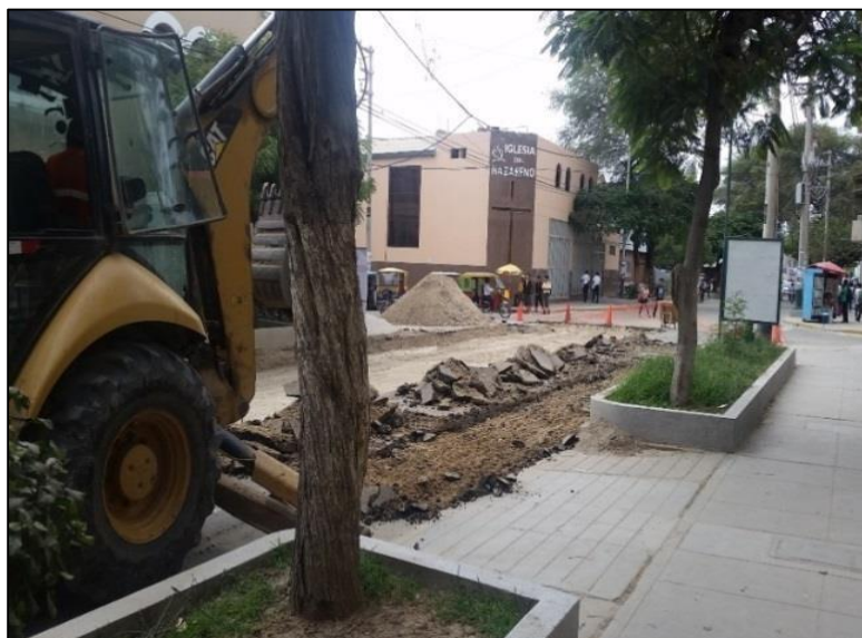
Figura 01: Cortes y Escarificado con Maquinaria
