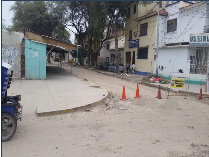
Figura 17: Av. Huancavelica tramo a realizar rehabilitación del pavimento de Richard Bussing
