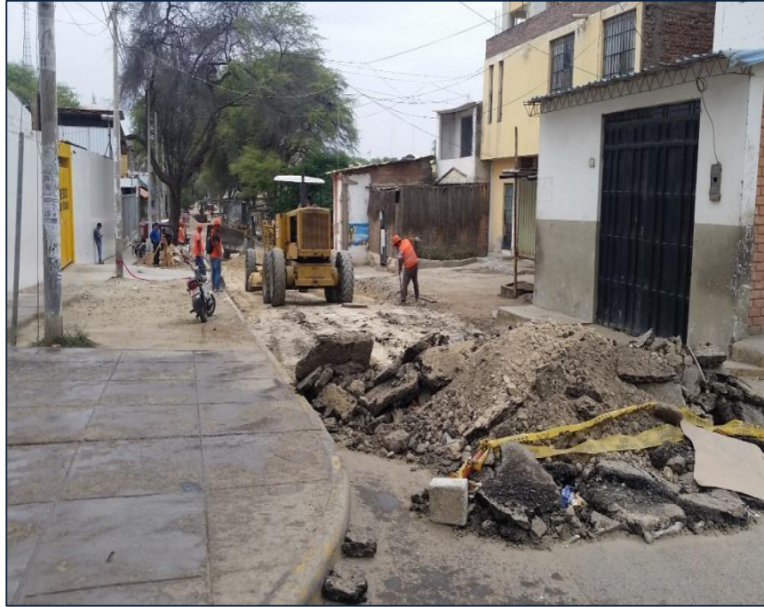
Figura 19: Av. Huancavelica tramo antes a rehabilitar vista de Av. San Martin hacia Richard Bussing.
