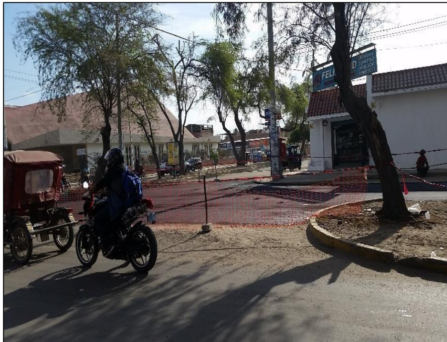
Figura 14: Av. Vice carpeta asfáltica cuadras 1, 2 y 3
