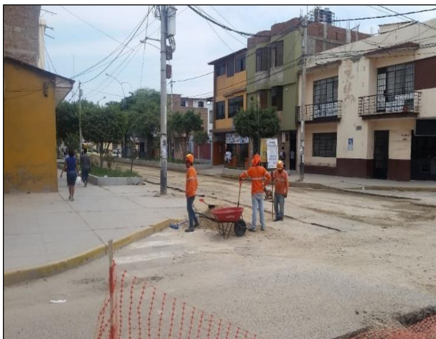
Figura 03: Limpieza Y Habilitación Del Terreno Para Imprimación
