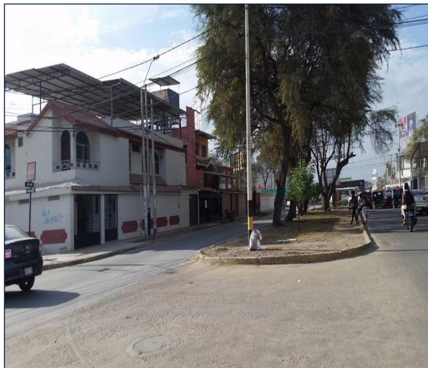
Figura 16: Av. Vice pavimento rehabilitado antes de colocar el slurry cuadra 1
