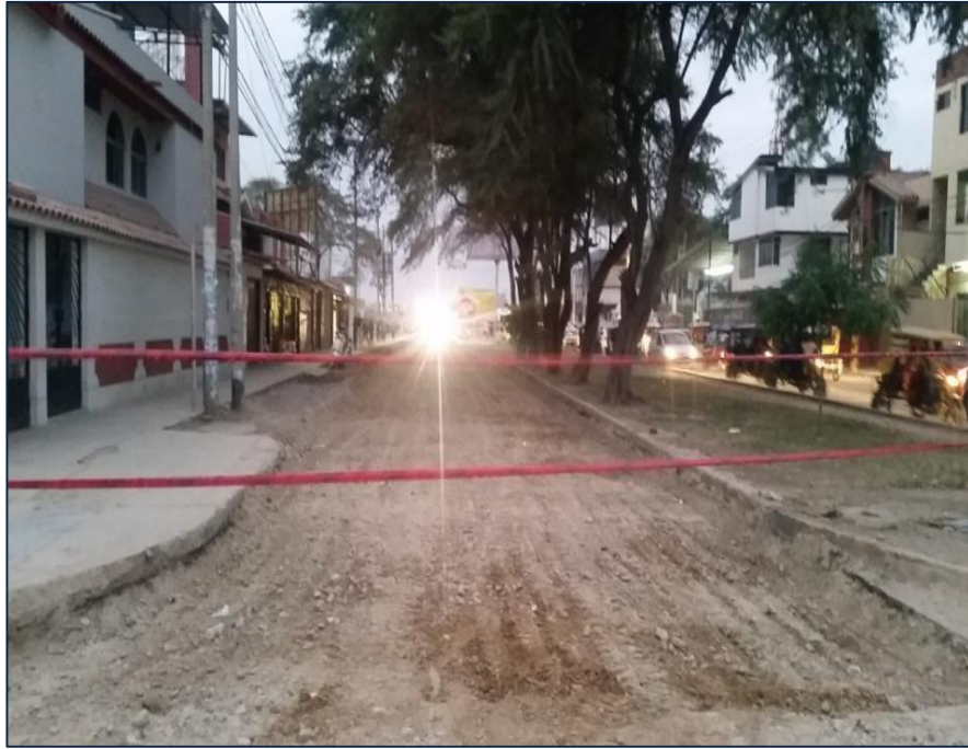
Figura 13: Av. Vice terreno habilitado para rehabilitación del pavimento cuadra 1
