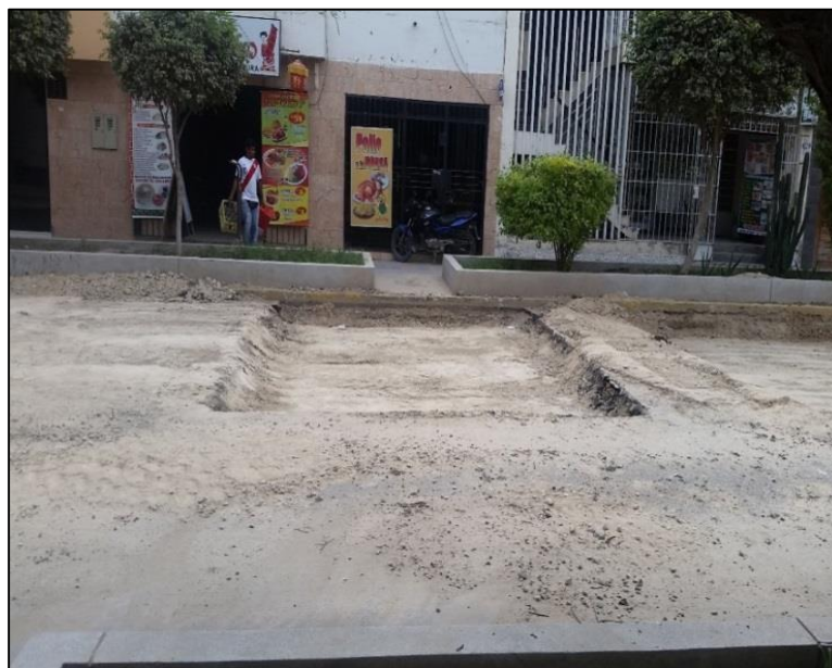
Figura 02: Secciones Preparadas para la Imprimación (Cuadra 9)
