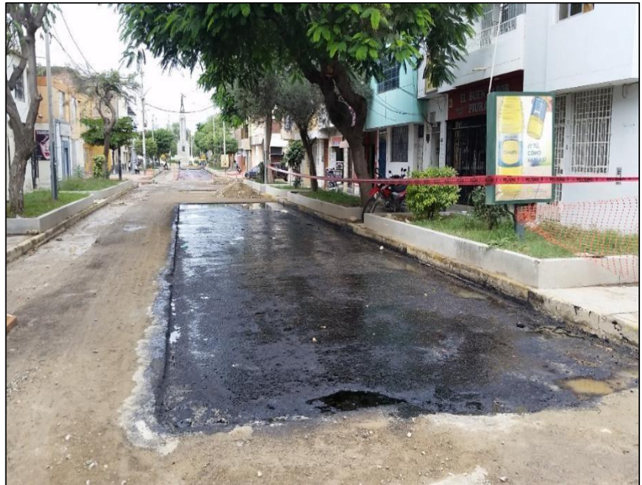
Figura 06: Habilitando para la carpeta asfáltica de las cuadras 9, 10 y 11.
