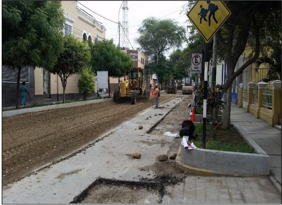
Figura 05 : Estabilizando La Base Con Hormigón y Cemento
