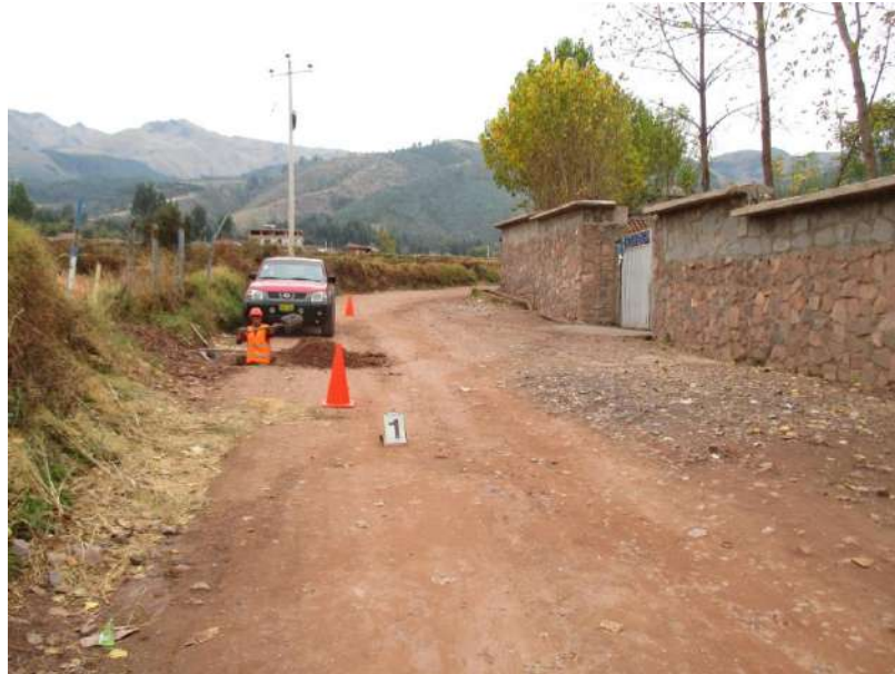
Figura N° 1- POZO N° 01 Vista de la ubicación de la calicata.
