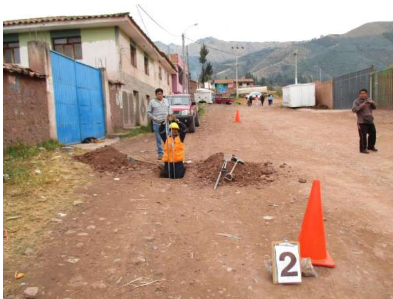
Figura N° 12 - POZO N° 02 Vista del Ensayo de PDL In Situ realizado en la calicata.
