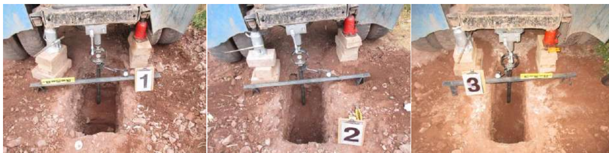
Ensayos con CBR In Situ
