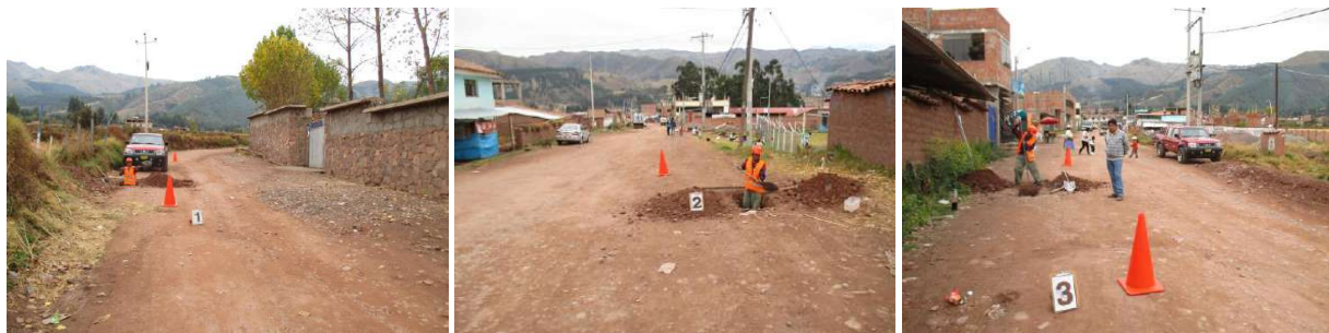
Pozos a Cielo abierto
