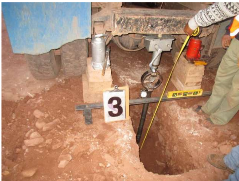
Figura N° 24 - POZO N° 03 Vista del Ensayo de CBR In Situ realizado en la calicata.
