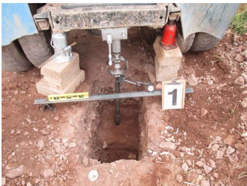
Figura N° 8 - POZO N° 01 Vista del Ensayo de CBR In Situ realizado en la calicata.
