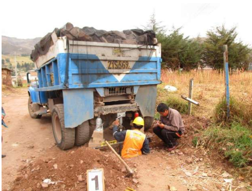
Figura N° 7 - POZO N° 01 Vista del Ensayo de CBR In Situ realizado en la calicata.
