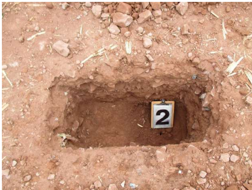
Figura Nº 10 - POZO Nº 02 Vista de la ubicación de la calicata y características del terreno.
