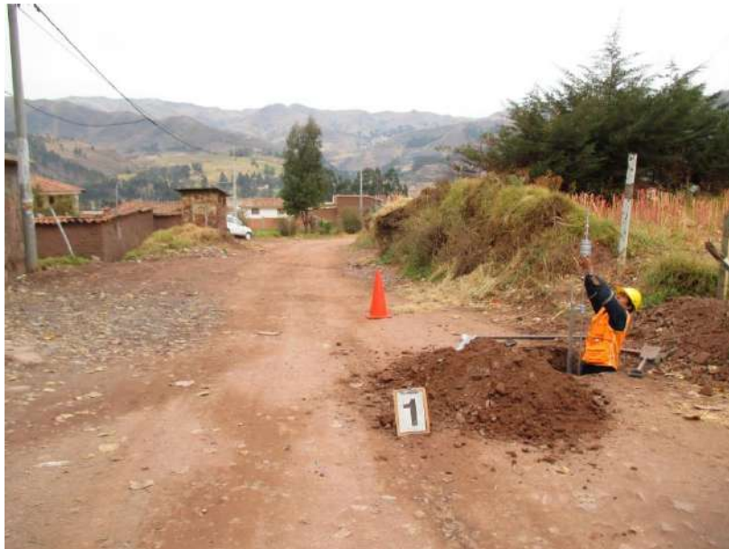
Figura N° 5- POZO N° 01 Vista del Ensayo de PDL In Situ realizado en la calicata.
