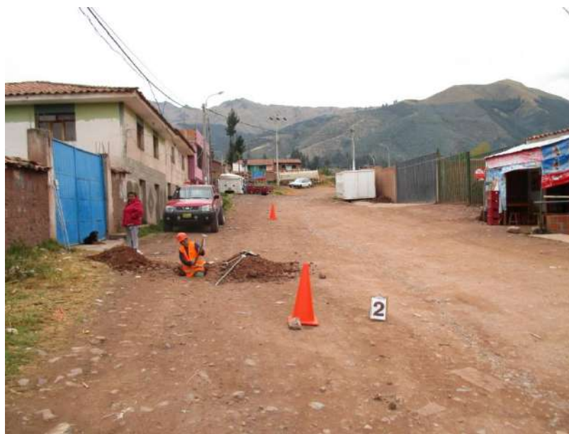
Figura Nº 9 - POZO Nº 02 Vista de la ubicación de la calicata.
