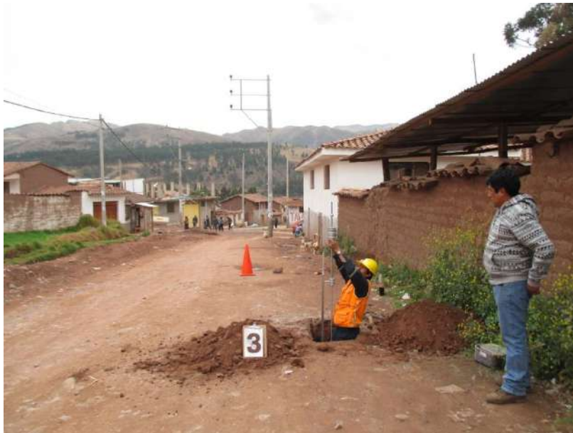
Figura N° 21 - POZO N° 03 Vista del Ensayo de PDL In Situ realizado en la calicata.
