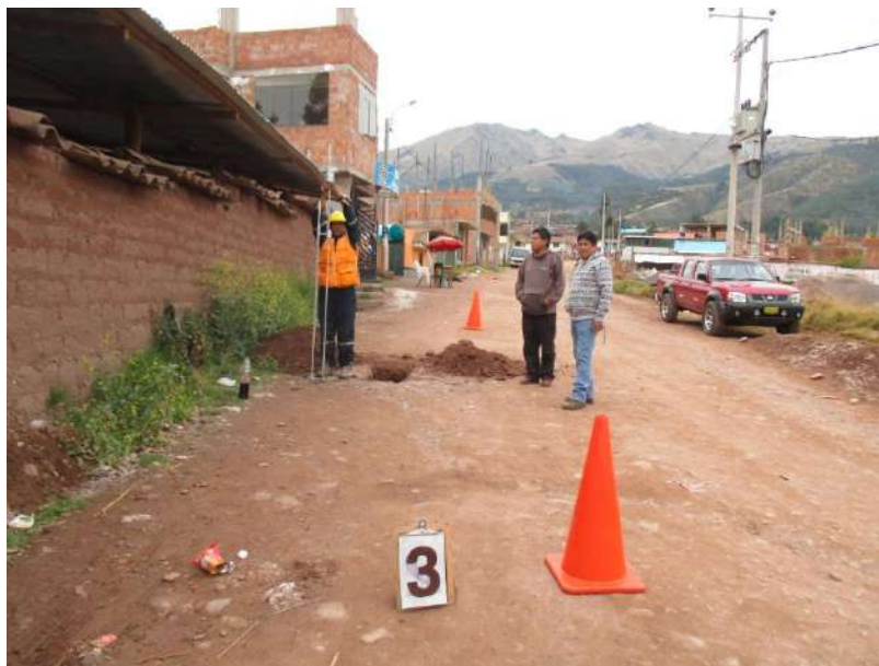
Figura N° 20 - POZO N° 03 Vista del Ensayo de PDL In Situ realizado en la calicata.
