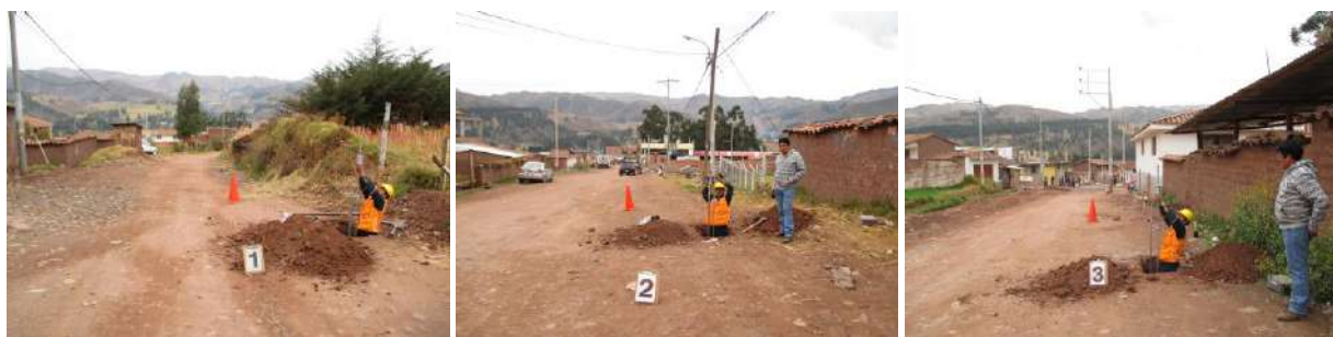
Ensayos con PDL In Situ
