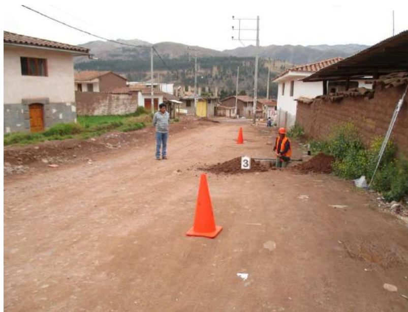
Figura N° 17- POZO N° 03 Vista de la ubicación de la calicata.
