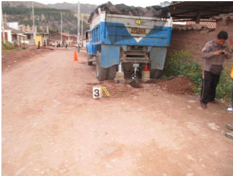
Figura N° 23 - POZO N° 03 Vista del Ensayo de CBR In Situ realizado en la calicata.
