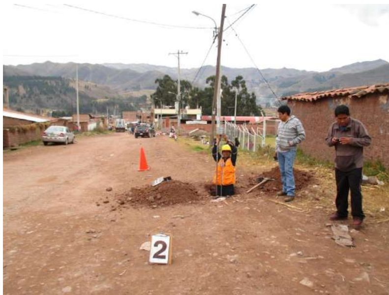
Figura N° 11 - POZO N° 02 Vista del Ensayo de PDL In Situ realizado en la calicata.
