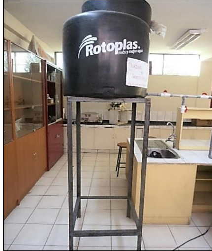
Figura 3.20: Soporte del Tanque de Alimentación
