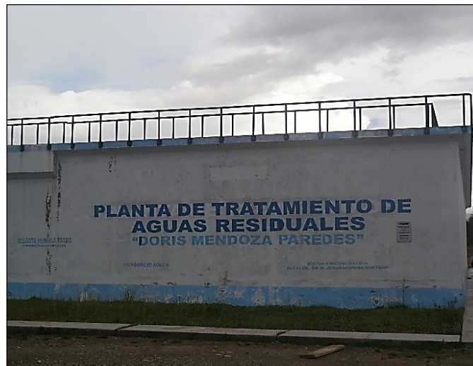
Figura 3.23: Planta de Tratamiento de Aguas Residuales "Doris Mendoza Paredes"
