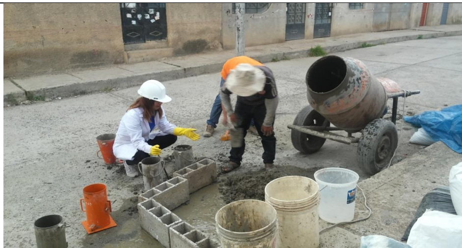
La fotografía evidencia el mezclado y la trabajabilidad del concreto con agregados de la cantera la sorpresa
