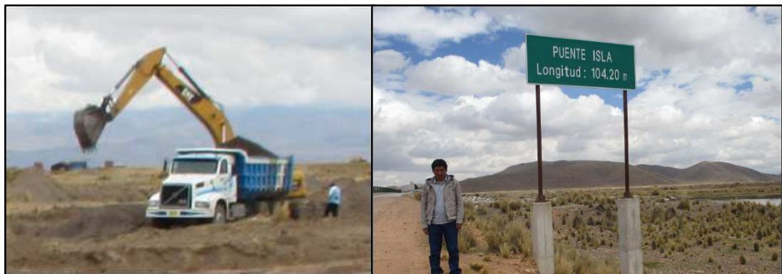
Figura 9. Extracción de los agregados de la cantera Isla - Juliaca
