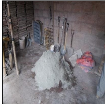
Mezclado de agregado.
