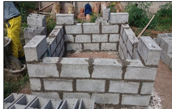
Proceso de asentado de bloques.
