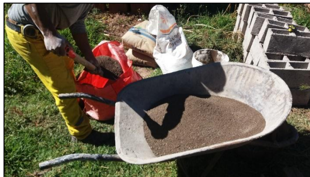
Foto 20. Mesclado de mortero
