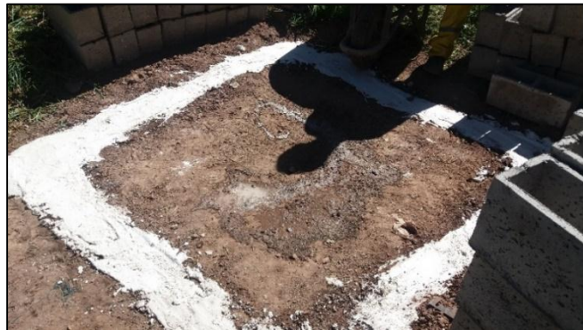
Foto 19. Trazo y replanteo para el asentado de bloques
