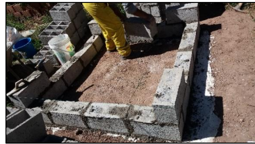
Proceso de asentado de bloques.
