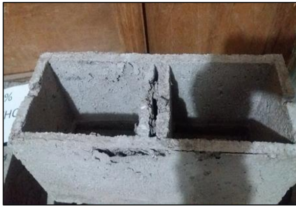
Descascaramiento parte central.
