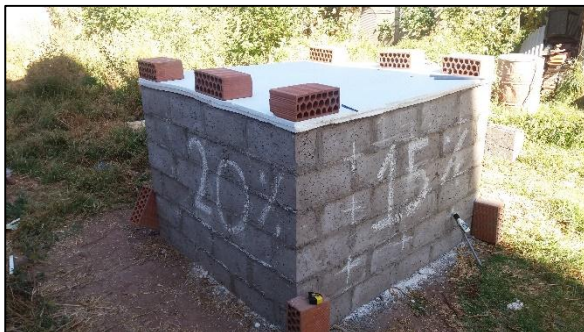
Foto 24. Colocación de planchas de tecnopor
