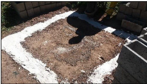
Trazo para asentado de bloques.
