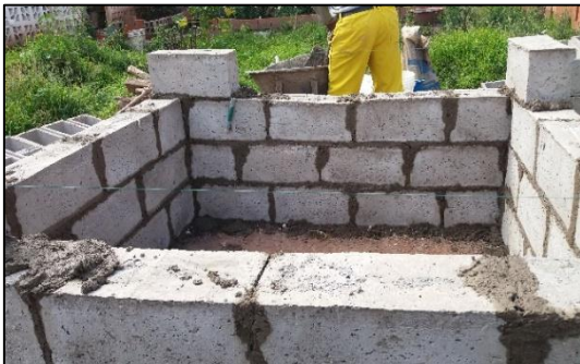
Proceso de asentado de bloques.
