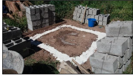
Trazo para asentado de bloques.
