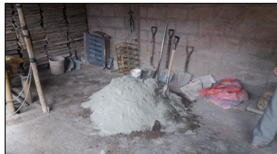
Foto 2. Mezclado del agregado con fibras de caucho
