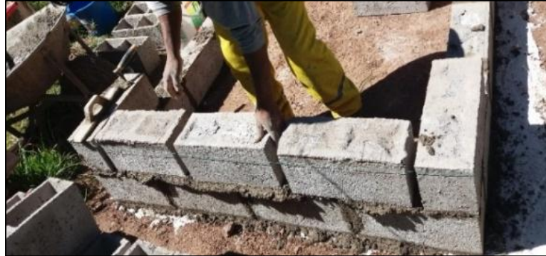
Foto 22. Nivelado y aplomado
