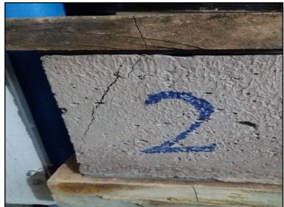
Presencia de fisura lateral.
